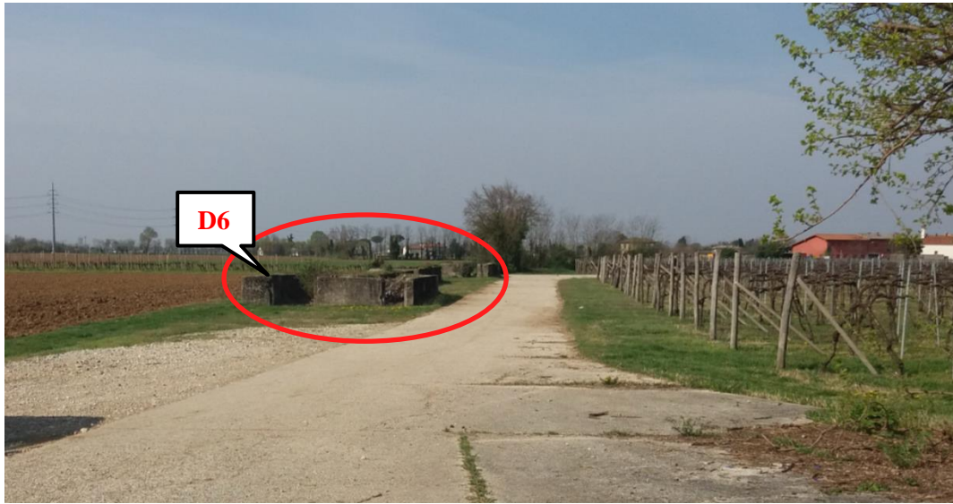
Figura 38 - Manufatti esistenti interferenti con l'asse stradale SL03
