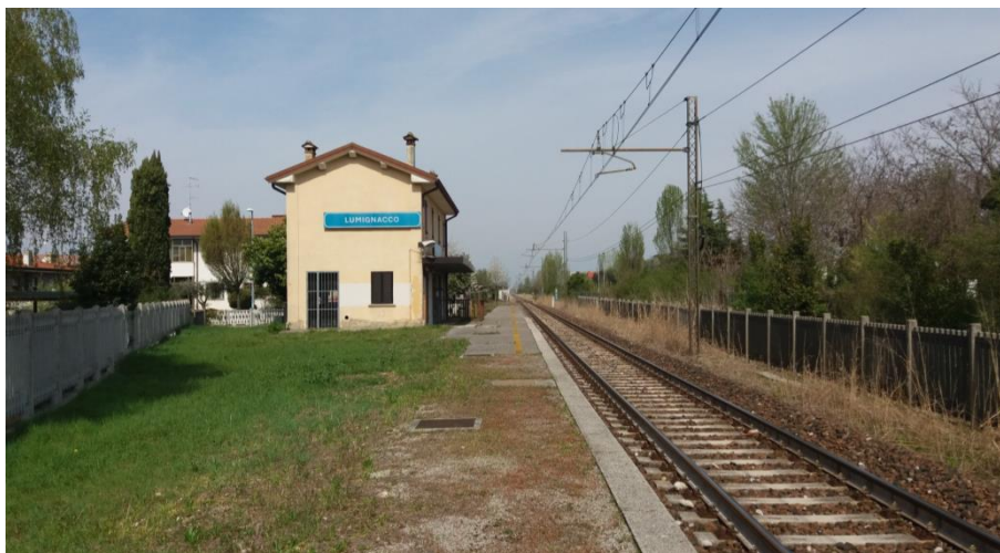
Figura 6 - Linea ferroviaria all'altezza della stazione di Lumignacco
