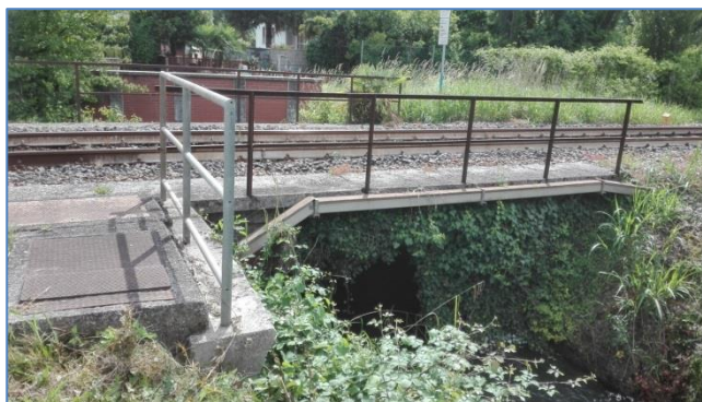
Figura 8 – Attraversamento binario di linea (lato ovest).
