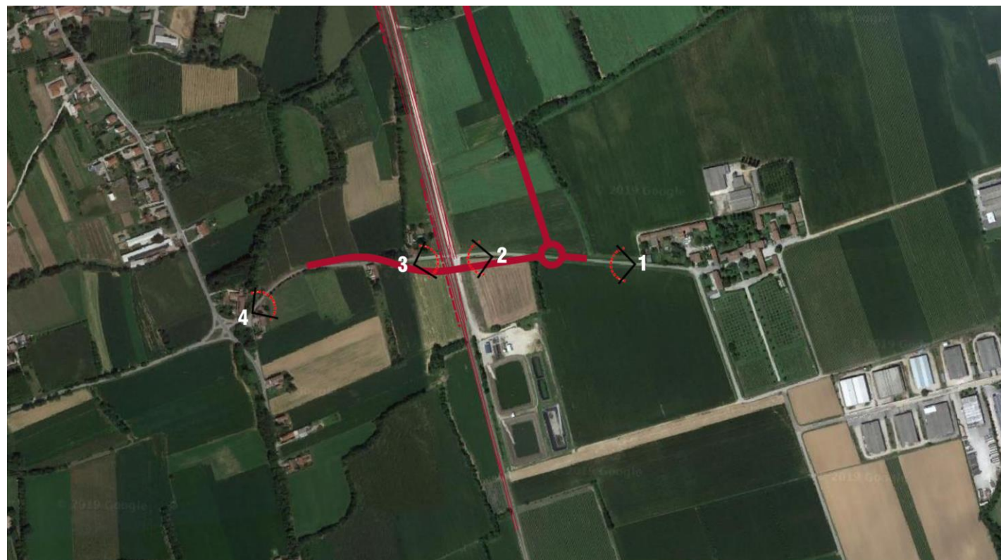
Inquadramento fotografico in corrispondenza di via Cortello Sottopasso SL02 - prog. Km 7+990
