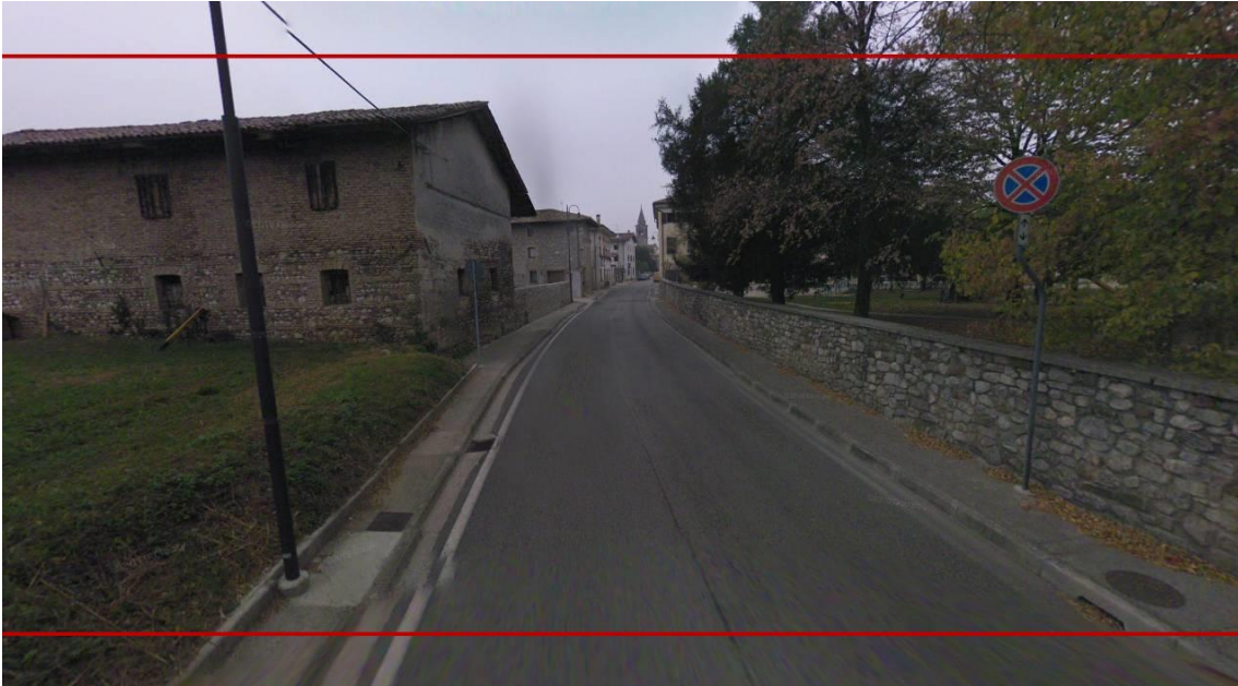
FIGURA 33 LUMIGNACCO TRATTO LUNGO VIA G.PASCOLI, TIPOLOGIE INSEDIATIVE DI CARATTERE STORICO
