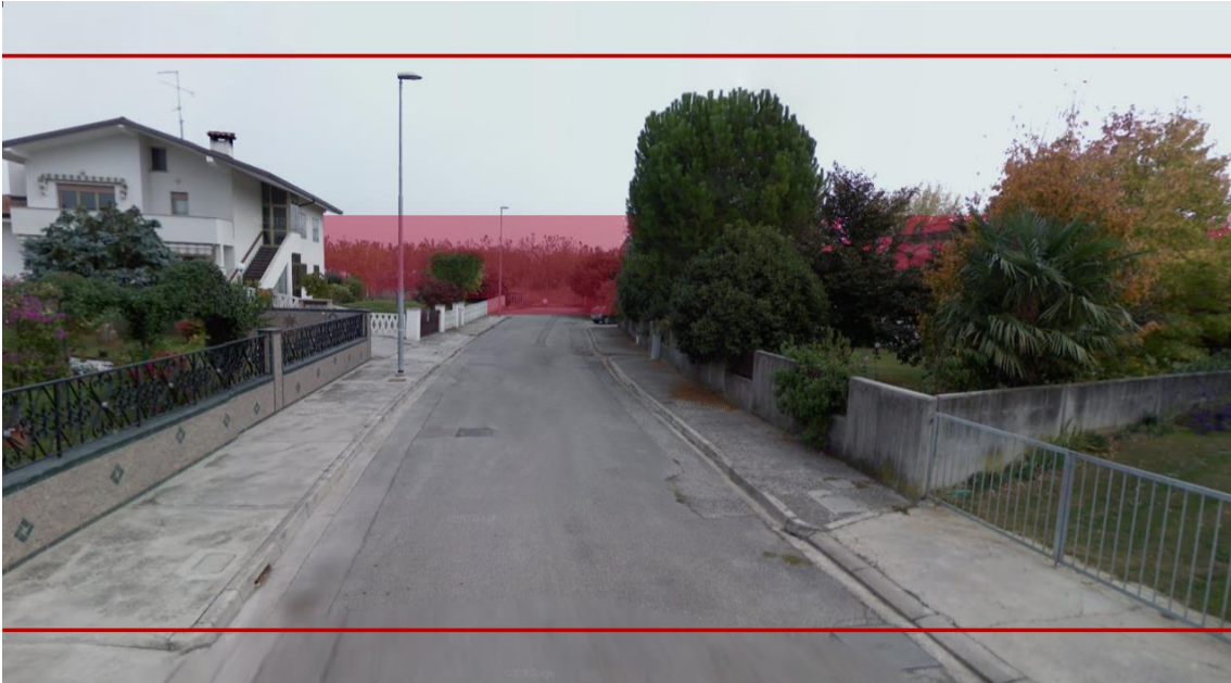
FIGURA 61 VIA G. GALILEI, LUMIGNACCO - BARRIERA ANTIRUMORE H10
