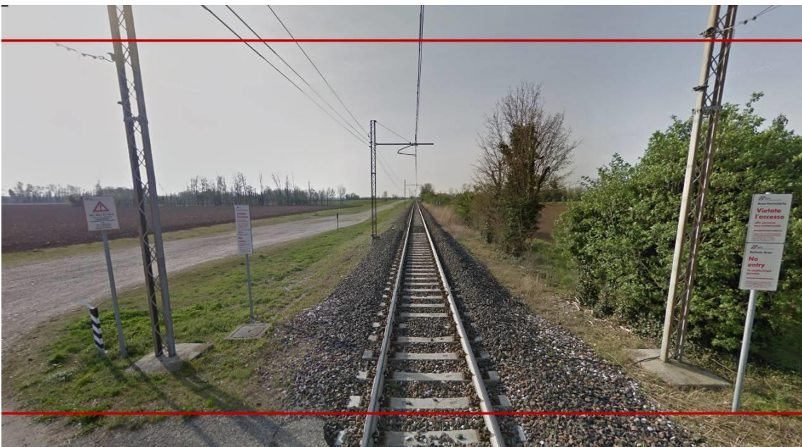
FIGURA 39 E FIGURA 40 E TRATTO DELLA LINEA UDINE PALMANOVA, PASSAGGIO A LIVELLO VIA DEI CAPITELLI, LUMIGNACCO
