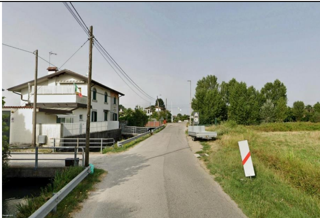
Figure 5-7 Stato attuale via Caiselli
