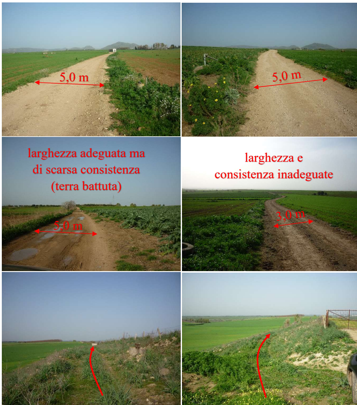
Figura 30 Alcune foto rappresentative della viabilità interna al parco eolico. In alto: viabilità esistente che può essere utilizzata così com'è; al centro: viabilità esistente da adeguare per essere percorsa dai mezzi; in basso: viabilità di nuova realizzazione prevalentemente su battuti/tracce esistenti.
