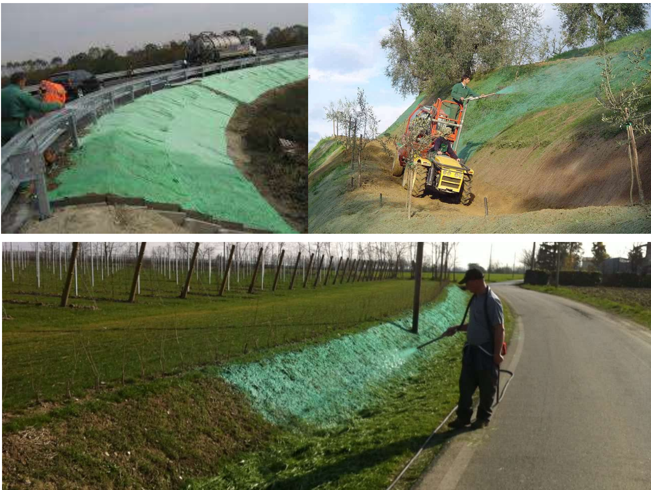
Figura 31: tecniche di idrosemina
