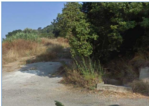
Figura 4.1 – Stato di fatto pista di accesso al deposito: degrado in alcuni punti e opere di scarico esistenti
