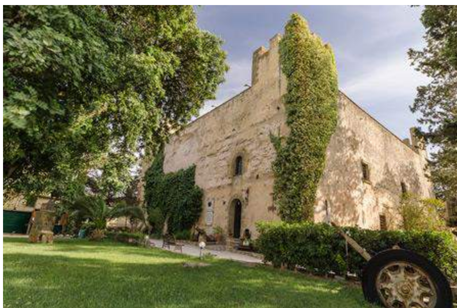
Figura 147 – Castello di Sanluri - Comune di Sanluri (VS) - Esterno
