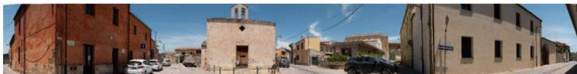
Stato di fatto del F34
