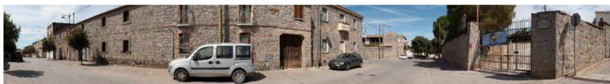
Stato di fatto del F18
