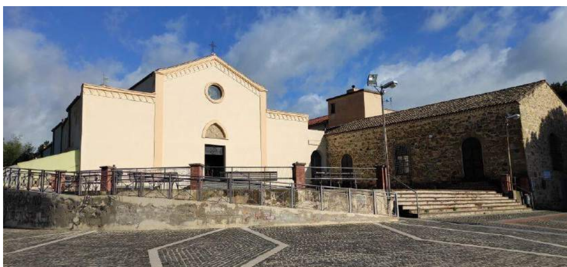
Figura 144 - Sanluri Chiesa di San Francesco d'Assisi
