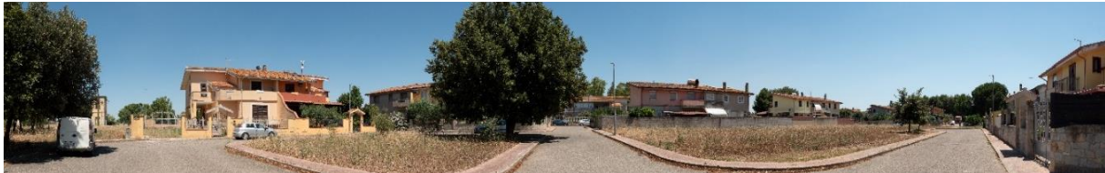
Stato di fatto del F28
