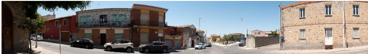
Stato di fatto del F36
