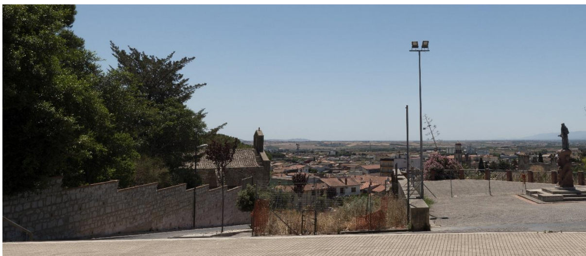
Stato di fatto del F37
