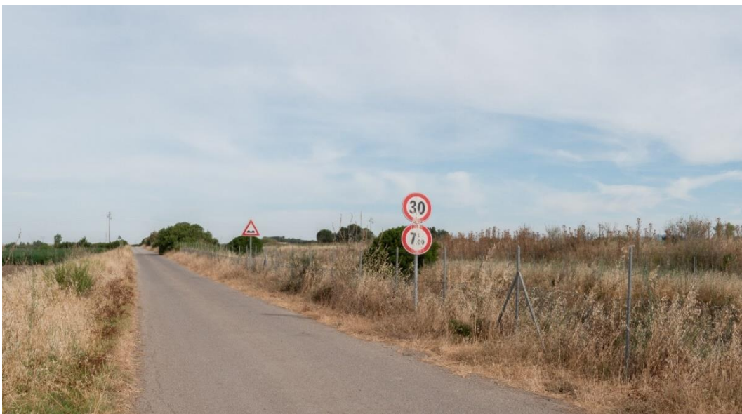
Stato di fatto del F17
