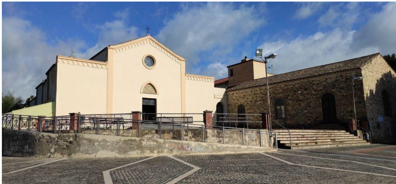
Figura 26 - Sanluri Chiesa di San Francesco d'Assisi
