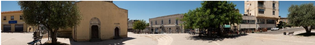
Stato di fatto del F31
