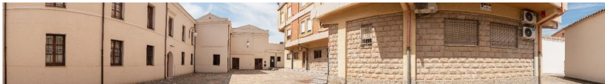
Stato di fatto del F67
