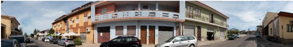
Stato di fatto del F27
