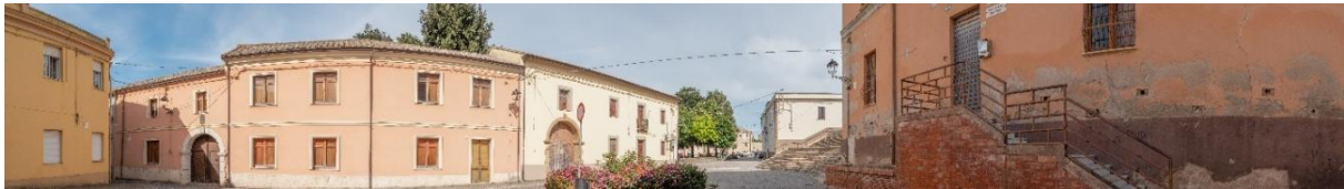
Stato di fatto del F63
