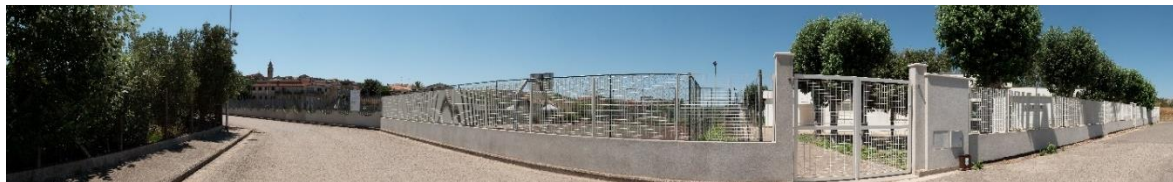
Stato di fatto del F39
