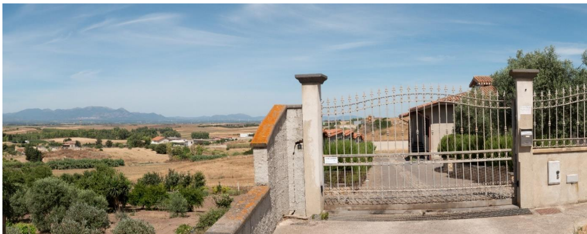
Stato di fatto del F14
