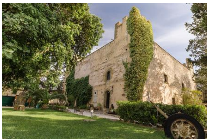
Figura 15 - Castello di Sanluri - Comune di Sanluri (VS) - Esterno
