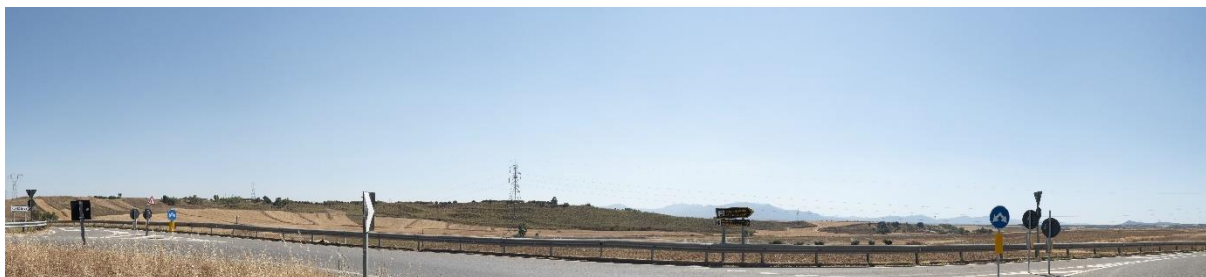
Stato di fatto del F49
