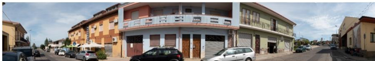
Stato di fatto del F27
