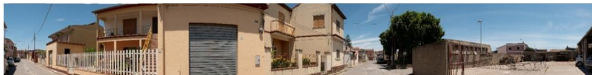
Stato di fatto del F19
