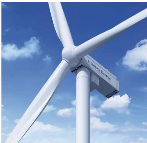
Figura 22 - Aerogeneratore Simens-Gamesa tipo – Navicella che ospita il trasformatore
