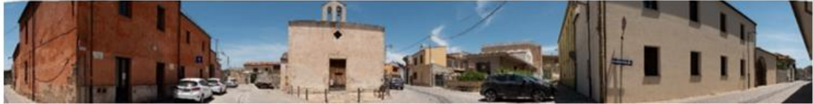
Stato di fatto del F34
