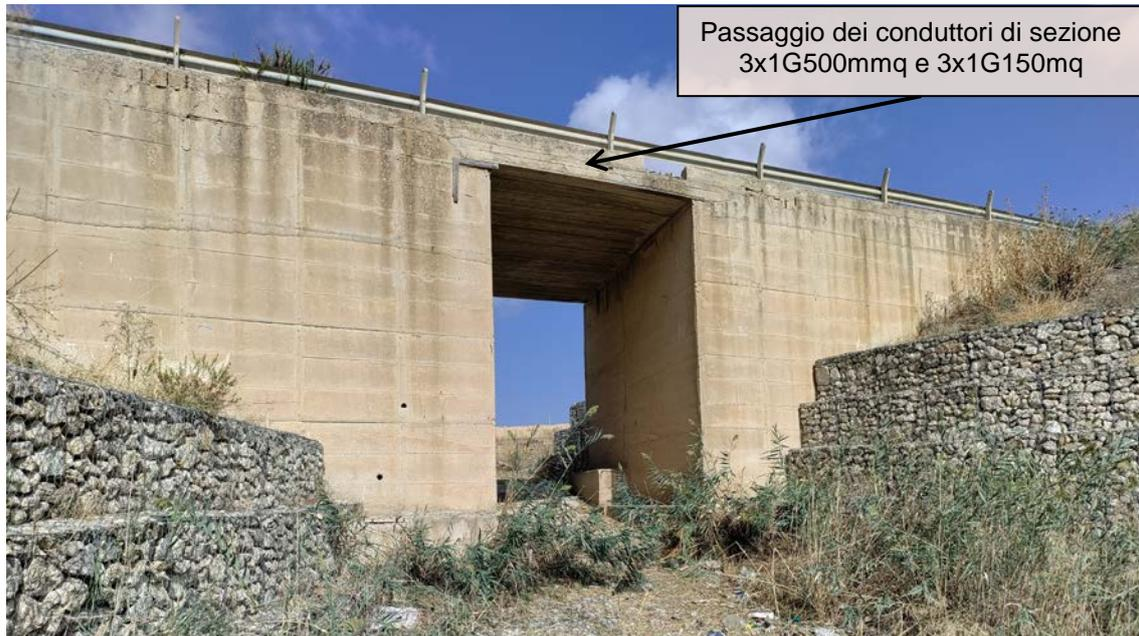
**Figura 6-10 – Interferenza “Ponte 4”, ipotesi di posizionamento dei conduttori**
