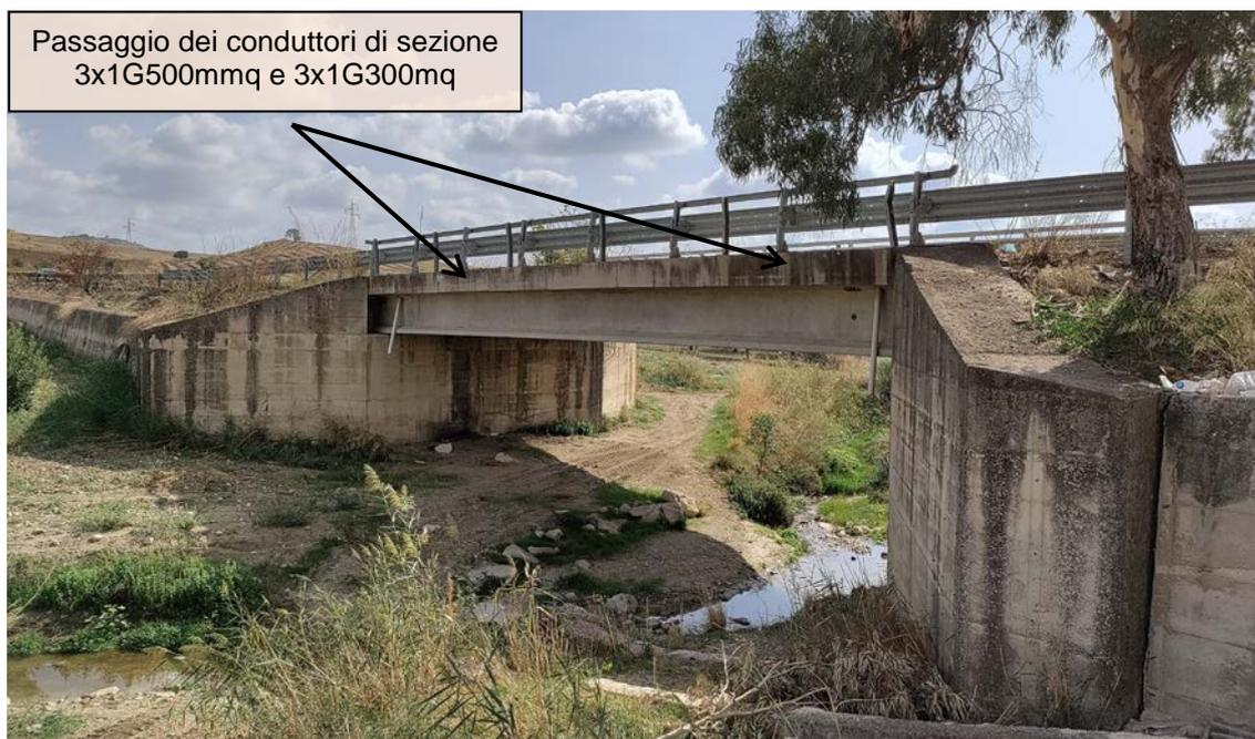
**Figura 6-7 – Interferenza “Ponte 3”, ipotesi di posizionamento dei conduttori**
