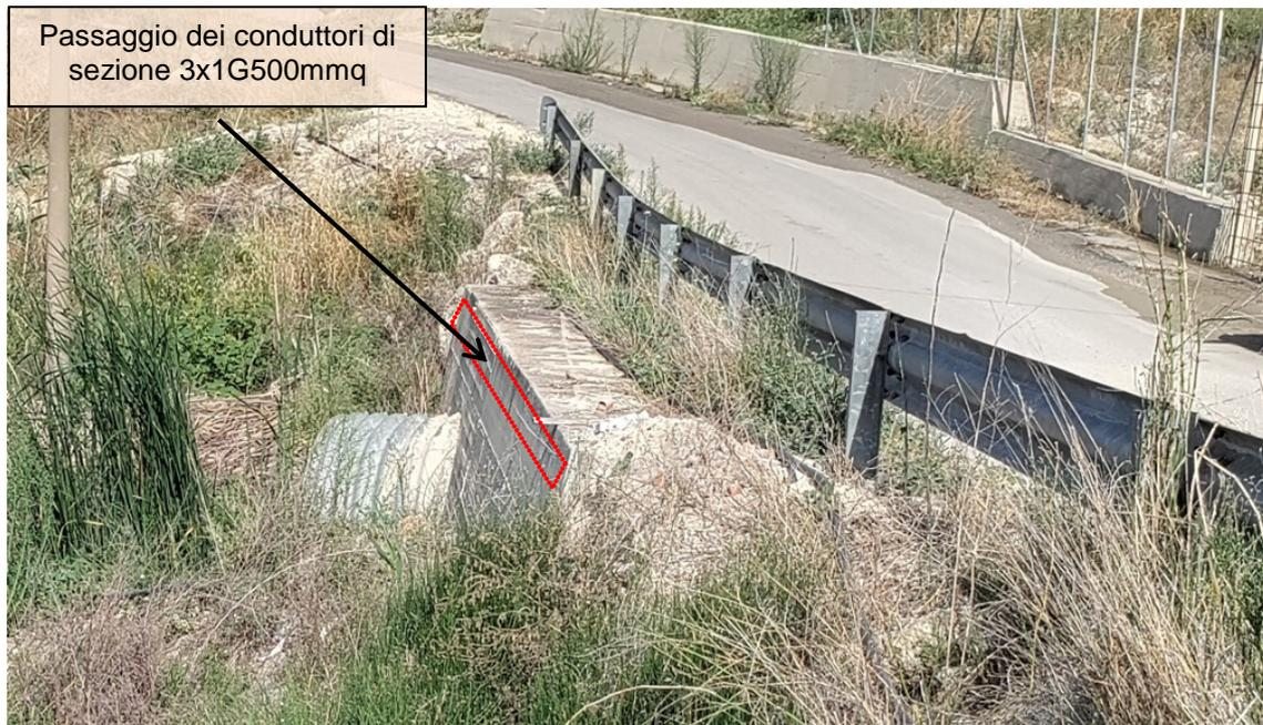
Figura 6-17 – Interferenza “Pozzetto 2”, ipotesi di posizionamento dei conduttori
