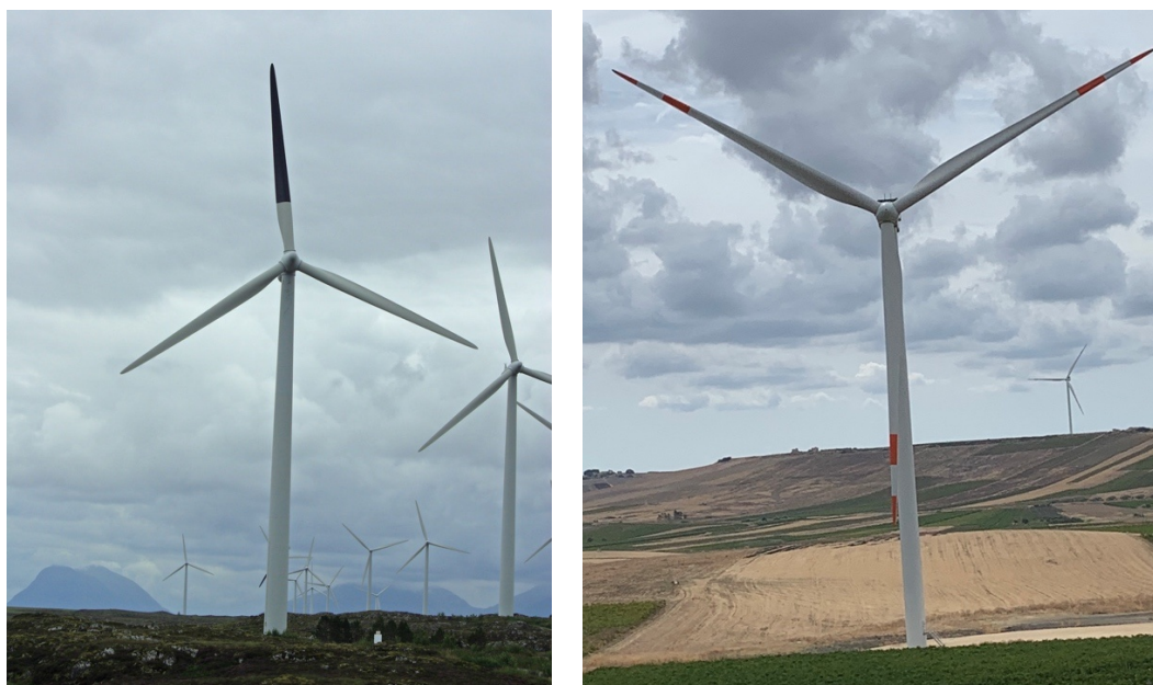
Figura 15-4 – Aerogeneratore con colorazione nera di una pala presso la centrale eolica di Smøla in Norvegia (sinistra) e aerogeneratore con pale a bande rosse (a destra) presso la centrale eolica "VRG Wind 060" della VGE nel territorio di Marsala (TP).
