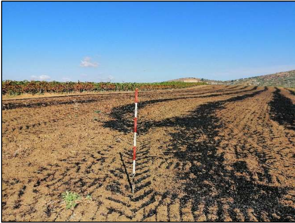
Area di cantiere
