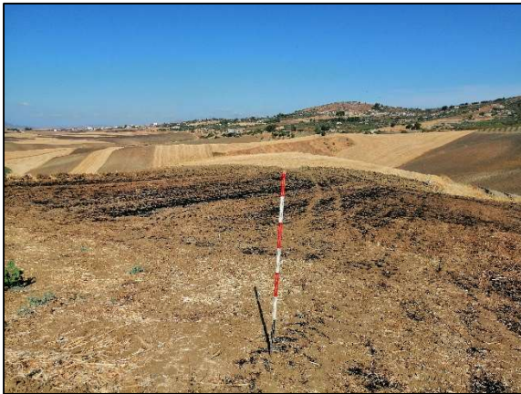
Sito installazione dell'aerogeneratore e piazzola di cantiere
