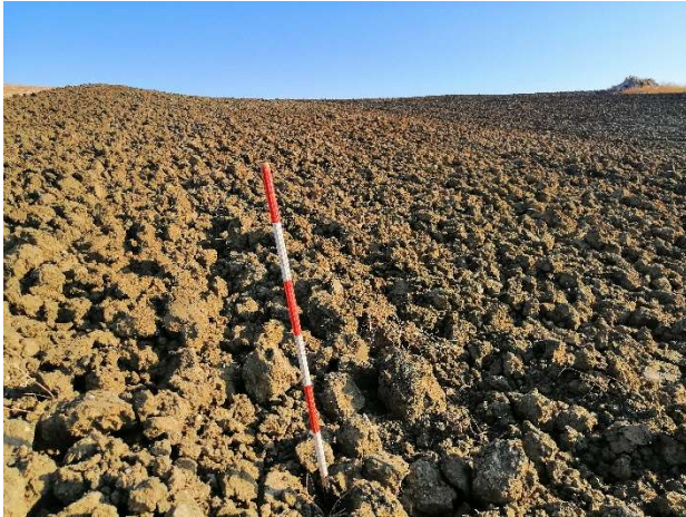
Area piazzola di cantiere
