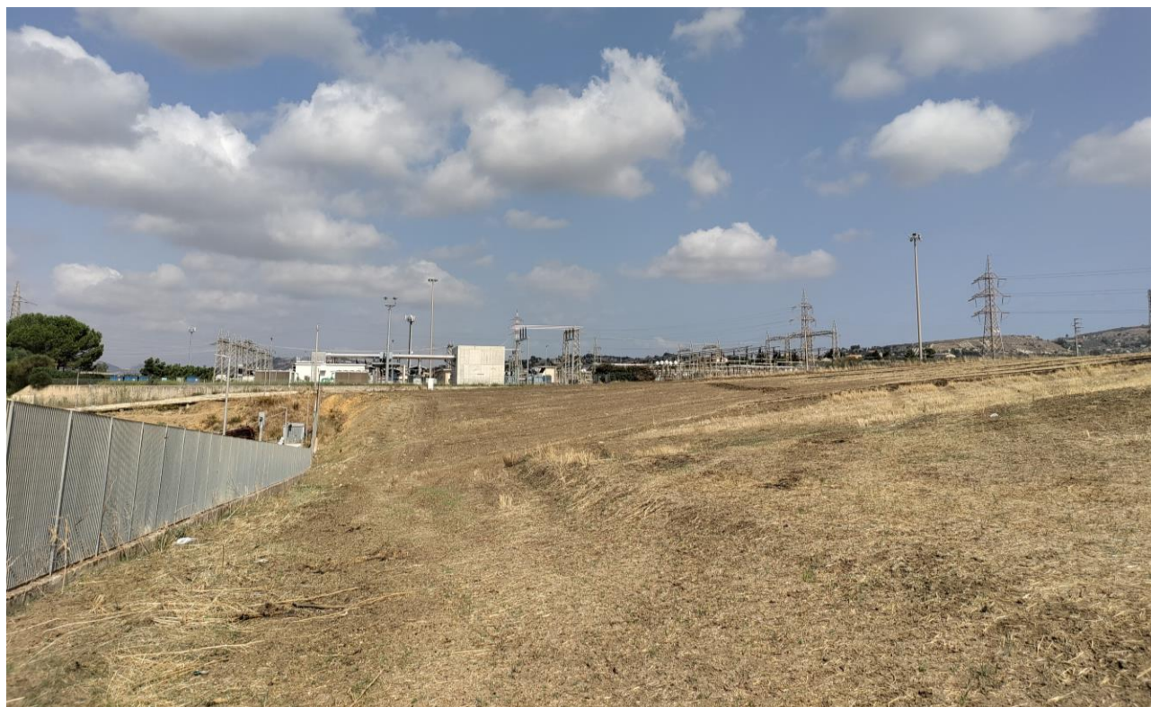
Figura 8-10 – SSE di Favara 220/150 kV e area prevista per la SSE di trasformazione 150/30 kV
