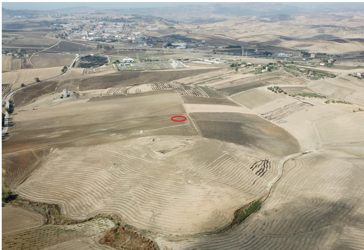
Figura 8-2 – Area prevista per l'installazione dell'aerogeneratore FV1
