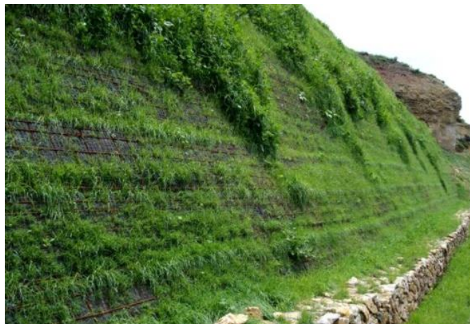
Figura 6-7 – Esempio di applicazione di terre rinforzate (fonte: pratiarmati.it)
