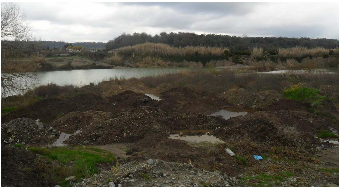
Figura 3.1.1 – Scavo ed intercettazione della falda
