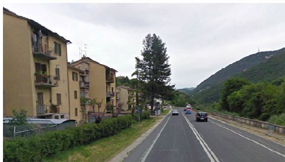
Veduta lungo la S.S. 3 Flaminia – direzione nord
