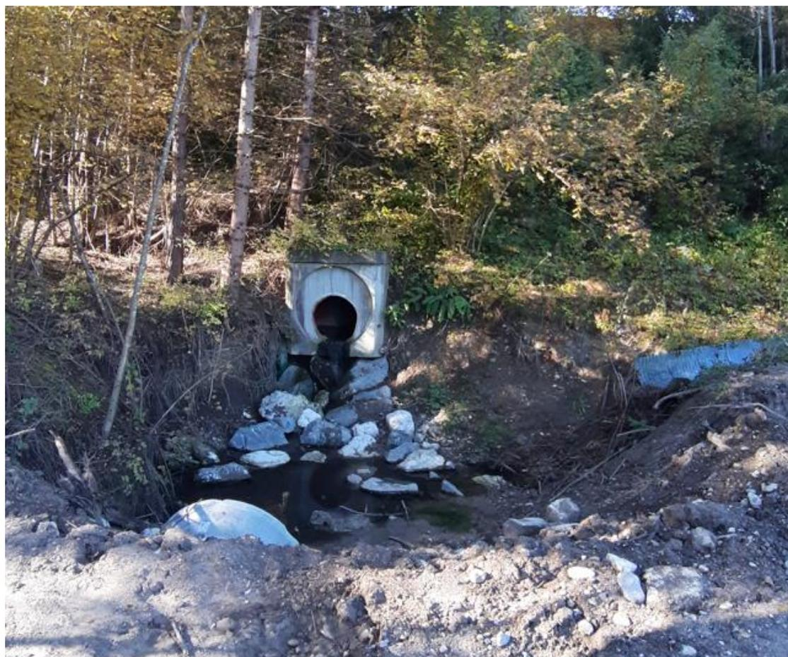
*Figura 5-7: Sbocco della tombinatura (Sopralluogo del 26.10.2021)*
