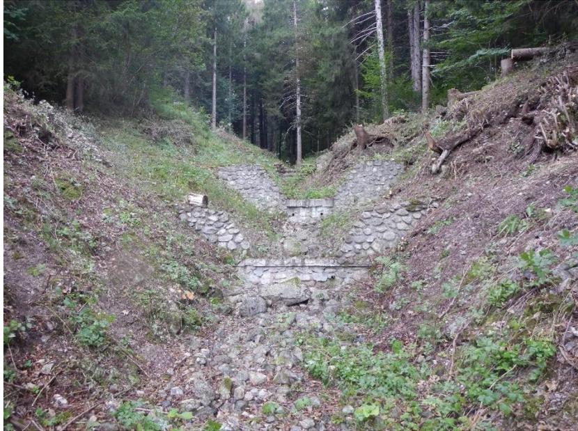
**Figura 5-39: Documentazione fotografica del sistema di briglie a monte dell'imbocco del tombino del Rio Malzago**
