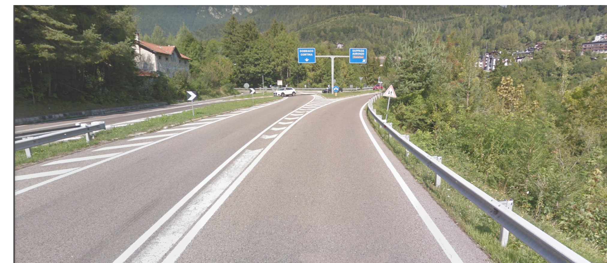
VIABILITA' IN PROSSIMITA' DELLA ROTATORIA EST - AREA DI CANTIERE 2
