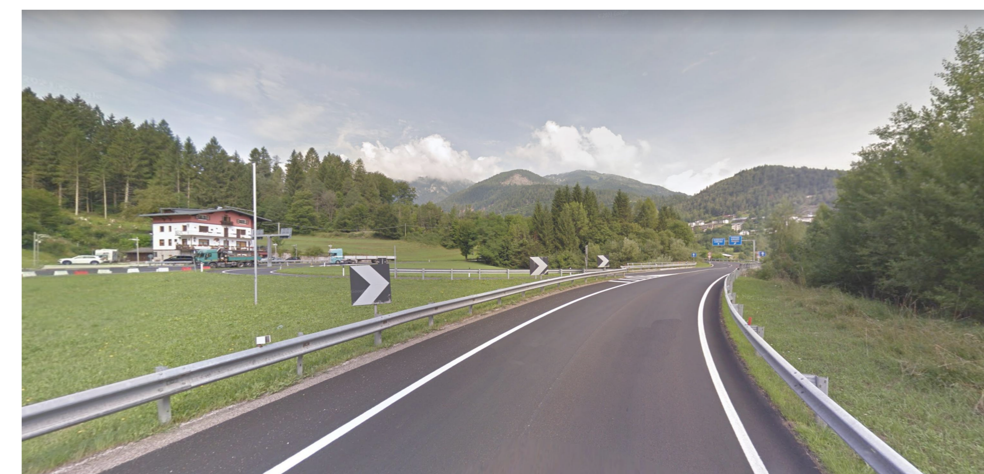
VIABILITA' IN PROSSIMITA' DELLA ROTATORIA EST - AREA DI CANTIERE 1
