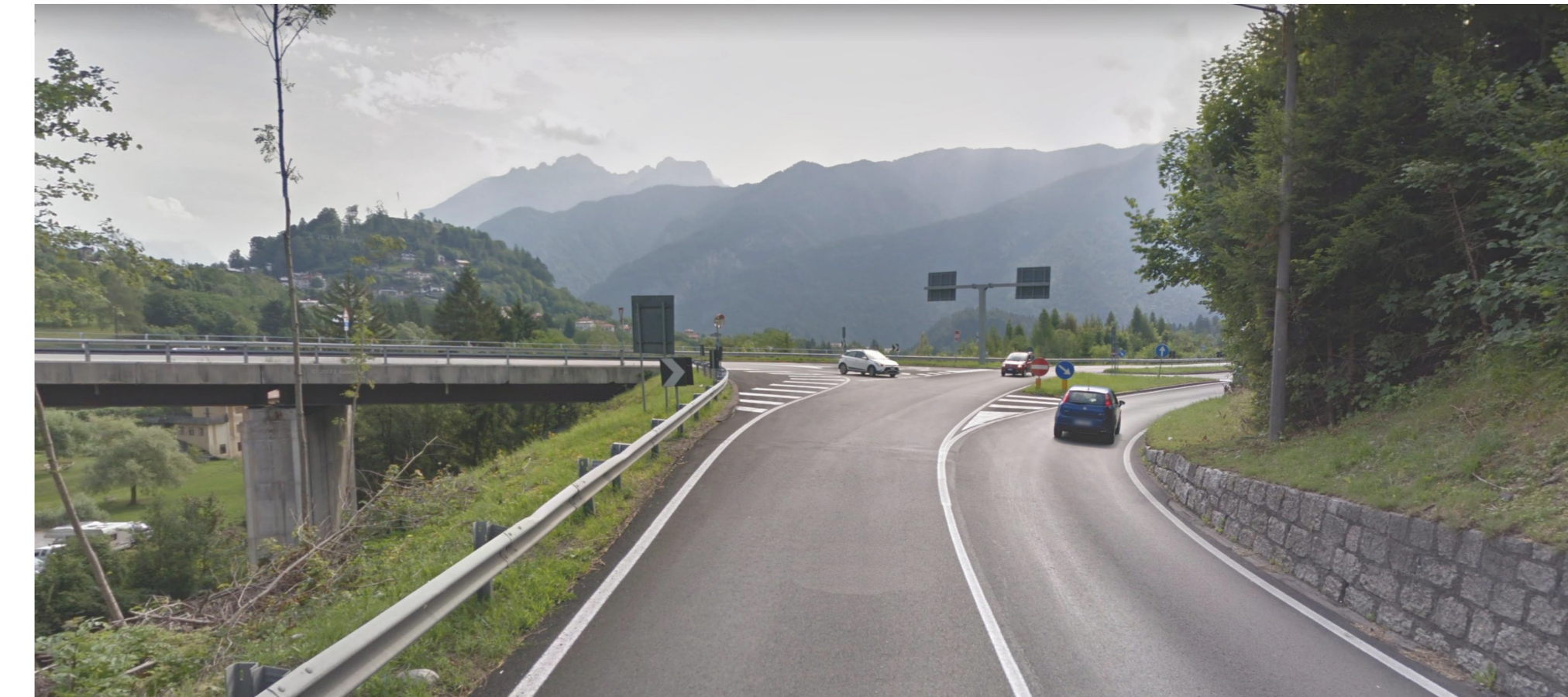
VIABILITA' IN PROSSIMITA' DELL'AREA DI CANTIERE 2
