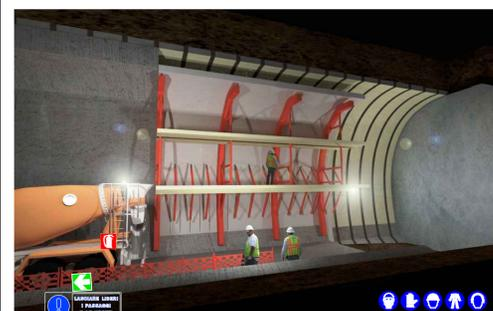
Il rivestimento definitivo viene realizzato utilizzando un apposito cassero metallico, costituito da un telaio portante su cui sono montate casseforme metalliche cilindriche. Il cassero, sostanzialmente, è composto da:
