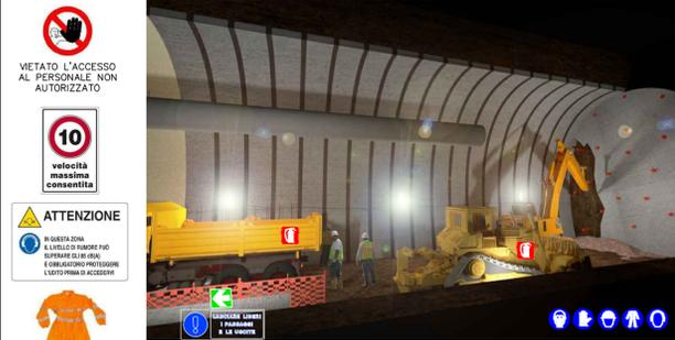
Lo scavo al fronte viene eseguito utilizzando un escavatore dotato di martello demolitore. Prima di dare inizio ai lavori, l'escavatorista verificherà il corretto funzionamento del climatizzatore di bordo. Durante lo scavo, la cabina dell'escavatore sarà tenuta chiusa.
