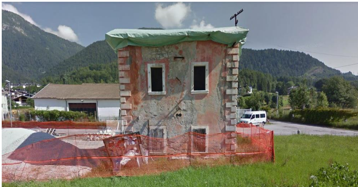
Figura 24 - Ex casello ferroviario di Tai di Cadore
