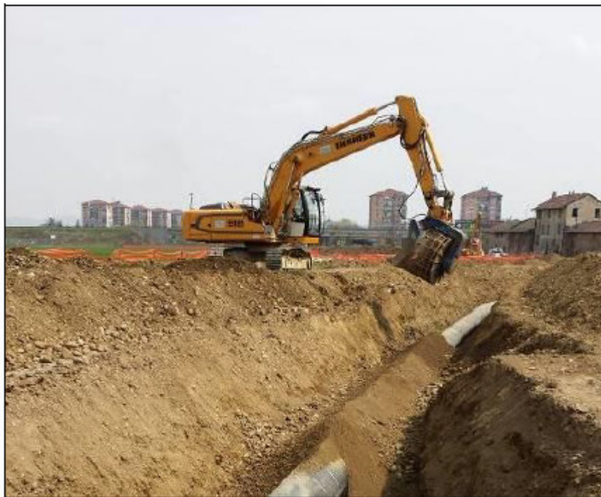
In figura: scatto fotografico riportante un esempio di “rinterro”
