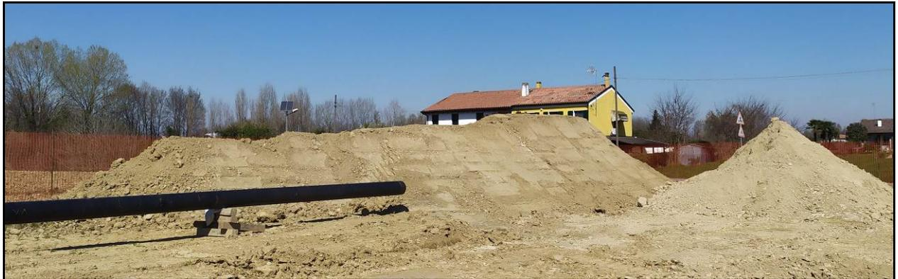
Fig. 5: Tipologia di barriere acustiche, banchetta di terra.
