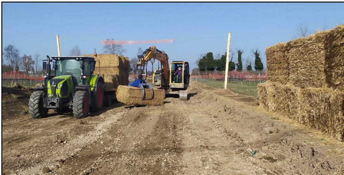
**Fig. 2: Foto rappresentativa della mobilitazione di barriere fonoassorbenti, tipologia balle di fieno rettangolari.**
