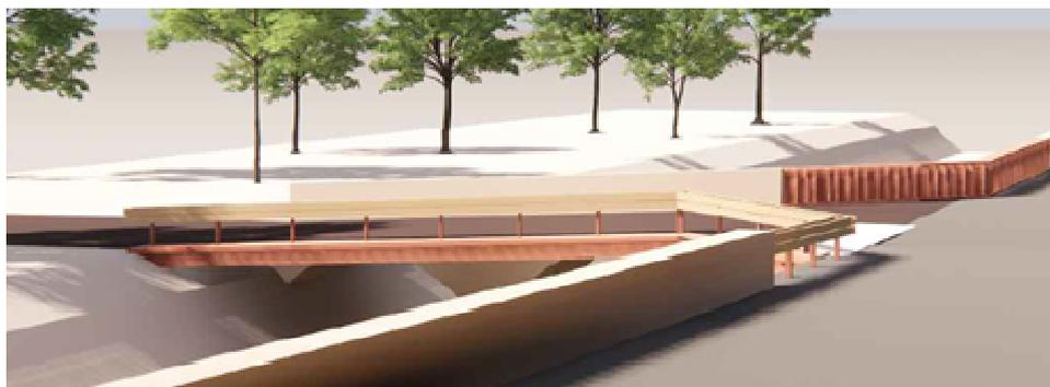
Il nuovo impalcato è realizzato ad altezza tale per cui l'intradosso sarà 30 cm più basso di quello della sola campata centrale, ma l'abbattimento della struttura in cemento armato sul lato di valle in adiacenza alla Strada Flaminia, fa sì che complessivamente la capacità di deflusso dell'intera sezione trasversale rimanga inalterata (si passa da 23,74 mq a 23,89 mq)
