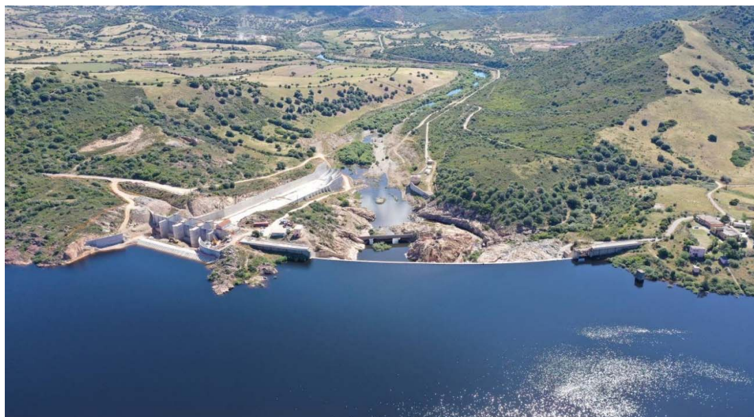
Figura 4-14 Vista est dell'area di intervento (Fonte: Rilievo fotografico mediante drone – anno 2020)
