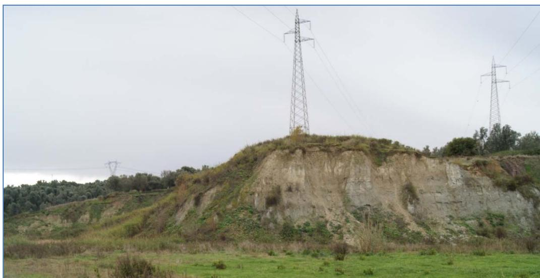
Figura 2.1 – Scarpata con scavo in abbandono
