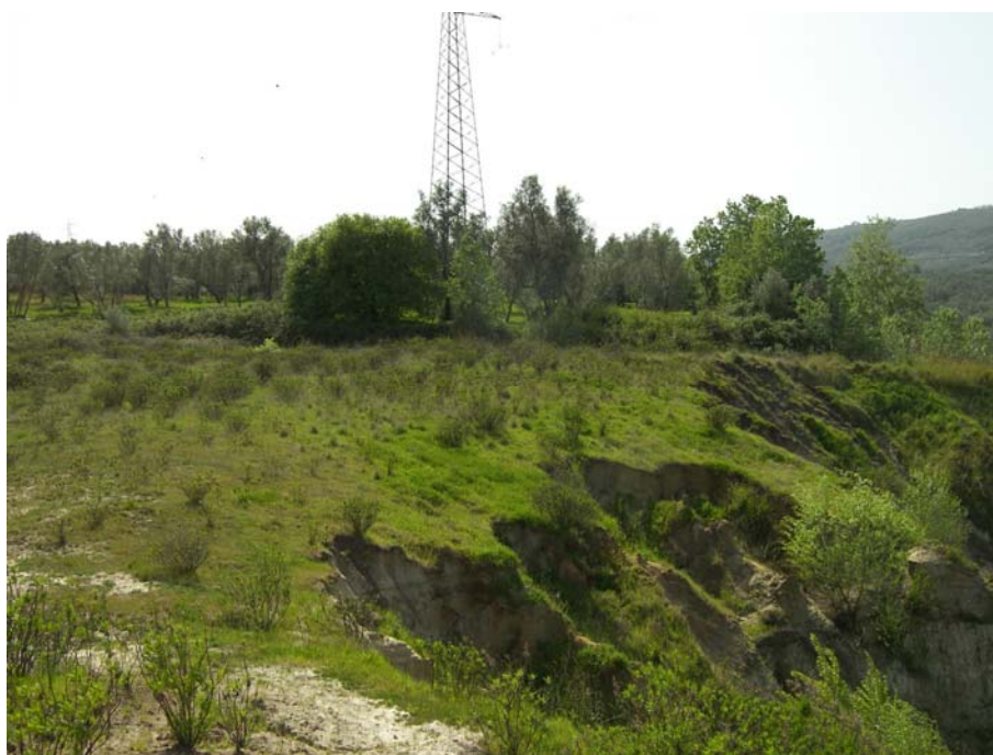
Solchi e fossi di erosione.
