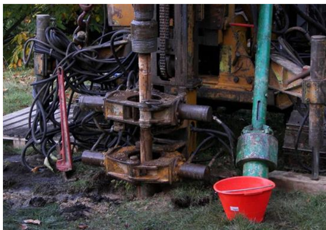
Figura 11: Macchina operatrice per la realizzazione di micropali tubfix. A sinistra sistema di scavo a rotopercolazione, a destra sistema di scavo mediante trivella elicoidale.
