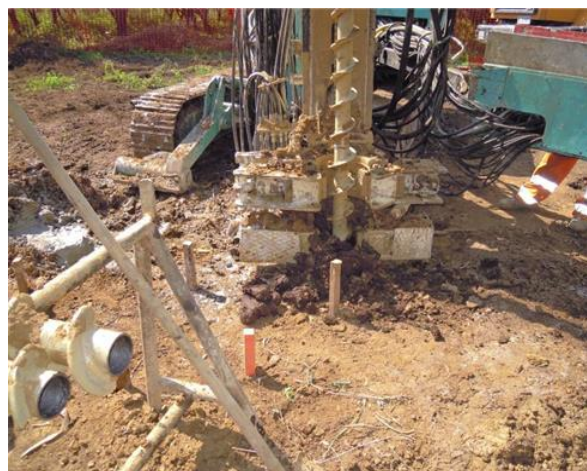
Figura 11: Macchina operatrice per la realizzazione di micropali tubfix. A sinistra sistema di scavo a rotopercolazione, a destra sistema di scavo mediante trivella elicoidale.
