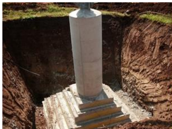
Figura 5: Realizzazione di fondazioni superficiali tipo CR per un sostegno a traliccio. Particolare durante la fase di casseratura (a sinistra) e al termine della stessa (a destra), dove si possono distinguere facilmente la parte inferiore a parallelepipedi tronco piramidali ed il colonnino di raccordo con la "base" del sostegno.
