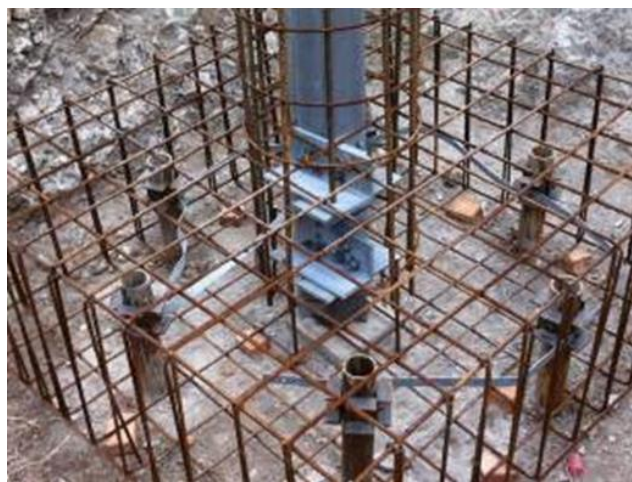
Figura 10: Esempio di realizzazione di fondazione su micropali tipo tubfix. Nell'immagine di destra è mostrato il raccordo tra i tubolari metallici dei micropali con l'armatura del plinto di fondazione; al centro del plinto si nota il moncone del sostegno (elemento di raccordo tra il sostegno e la fondazione), inglobato nella fondazione stessa.
