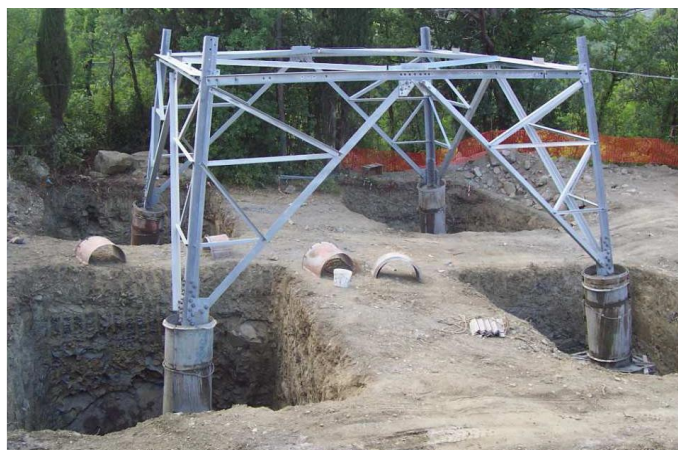
Figura 6: Realizzazione di fondazioni superficiali tipo CR per un sostegno a traliccio. Nell'immagine si possono osservare le quattro buche, la base del sostegno collegata alla fondazione tramite i "monconi" ed i casseri utilizzati per i quattro "colonnini".
