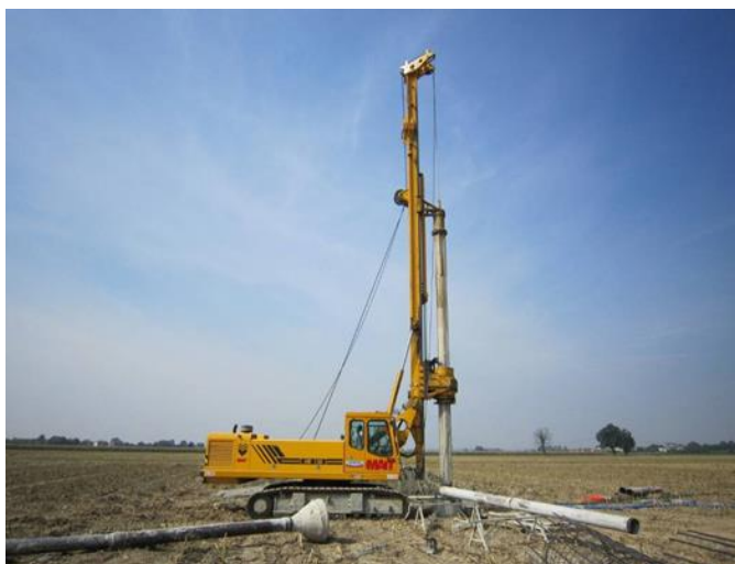
Figura 8: Macchina operatrice per la realizzazione di pali trivellati e fondazione in fase di realizzazione
