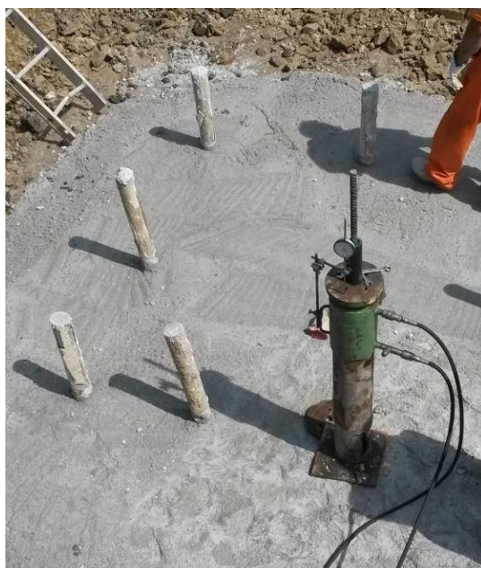
Figura 12: Realizzazione di micropali tipo tubfix per un sostegno a traliccio. Particolare di micropali già realizzati ed iniettati durante la prova di tenuta del micropalo allo strappamento, al fine di verificare la corretta progettazione e realizzazione dello stesso, eseguita prima dell'armatura e casseratura del plinto di fondazione.
