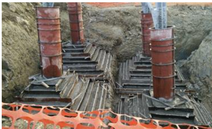
Figura 5: Realizzazione di fondazioni superficiali tipo CR per un sostegno a traliccio. Particolare durante la fase di casseratura (a sinistra) e al termine della stessa (a destra), dove si possono distinguere facilmente la parte inferiore a parallelepipedi tronco piramidali ed il colonnino di raccordo con la "base" del sostegno.
