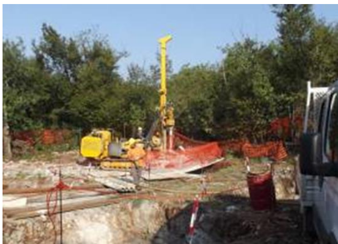
Figura 10: Esempio di realizzazione di fondazione su micropali tipo tubfix. Nell'immagine di destra è mostrato il raccordo tra i tubolari metallici dei micropali con l'armatura del plinto di fondazione; al centro del plinto si nota il moncone del sostegno (elemento di raccordo tra il sostegno e la fondazione), inglobato nella fondazione stessa.
