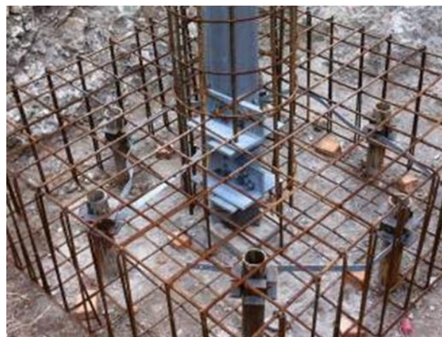
Figura 11: Esempio di realizzazione di fondazione su micropali tipo tubfix. Nell'immagine di destra è mostrato il raccordo tra i tubolari metallici dei micropali con l'armatura del plinto di fondazione; al centro del plinto si nota il moncone del sostegno (elemento di raccordo tra il sostegno e la fondazione), inglobato nella fondazione stessa.
