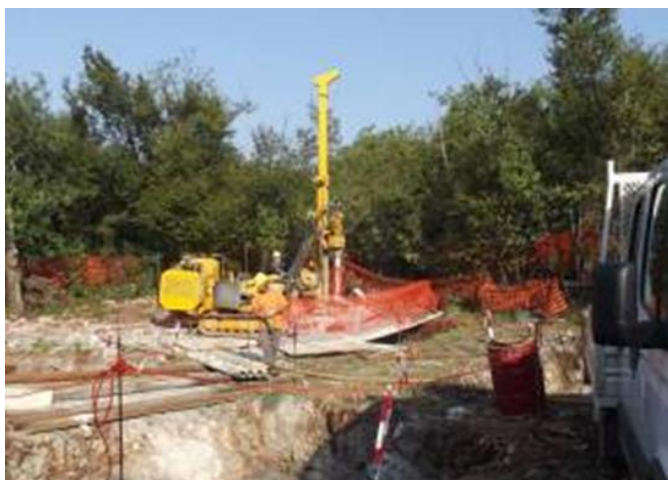
Figura 11: Esempio di realizzazione di fondazione su micropali tipo tubfix. Nell'immagine di destra è mostrato il raccordo tra i tubolari metallici dei micropali con l'armatura del plinto di fondazione; al centro del plinto si nota il moncone del sostegno (elemento di raccordo tra il sostegno e la fondazione), inglobato nella fondazione stessa.
