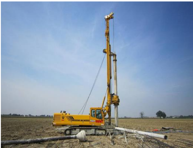
Figura 9: Macchina operatrice per la realizzazione di pali trivellati
