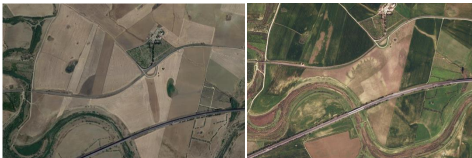
Figura 44: Passaggio dei sostegni 45-46-47 ((Elettrodotto Assoro-Regalbuto) 61-62-63 (elettrodotto Regalbuto-Sferro) e Stazione Elettrica Regalbuto. (Contrada Sparagogna, scheda 7)
