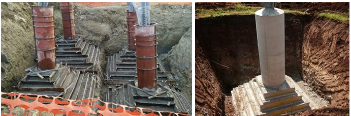
Figura 6: Realizzazione di fondazioni superficiali tipo CR per un sostegno a traliccio. Particolare durante la fase di casseratura (a sinistra) e al termine della stessa (a destra), dove si possono distinguere facilmente la parte inferiore a parallelepipedi tronco piramidali ed il colonnino di raccordo con la “base” del sostegno
