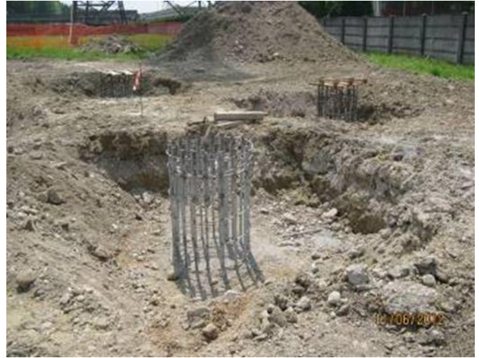
Figura 9: Macchina operatrice per la realizzazione di pali trivellati e fondazione in fase di realizzazione
