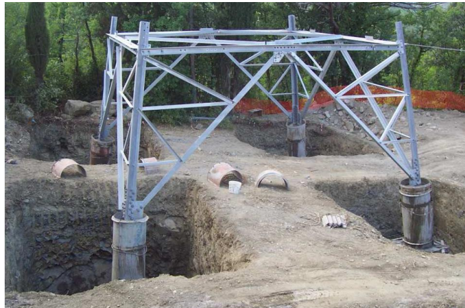
Figura 7: Realizzazione di fondazioni superficiali tipo CR per un sostegno a traliccio. Nell'immagine si possono osservare le quattro buche, la base del sostegno collegata alla fondazione tramite i "monconi" ed i casseri utilizzati per i quattro "colonnini"
