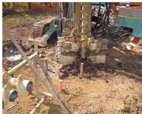
Figura 12: Macchina operatrice per la realizzazione di micropali tubfix. A sinistra sistema di scavo a rotopercussione, a destra sistema di scavo mediante trivella elicoidale
