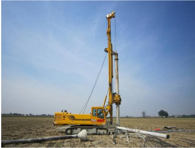
Figura 9: Macchina operatrice per la realizzazione di pali trivellati e fondazione in fase di realizzazione
