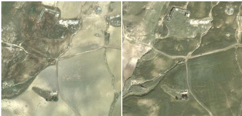
Figura 43: Contrada Desticella area sostegni da 09 a 13 (Elettrodotto Assoro-Regalbuto)
