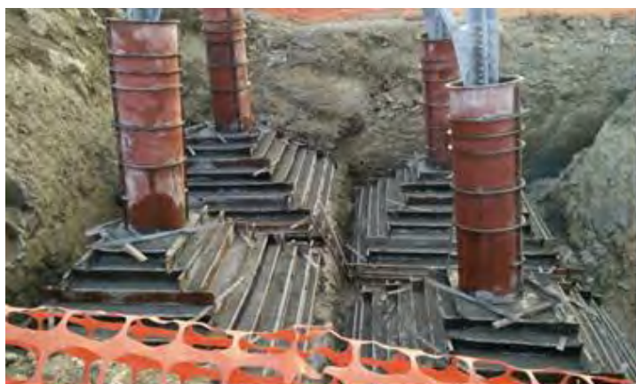
Figura 69: Realizzazione di fondazioni superficiali tipo CR per sostegno a traliccio. Particolare durante la fase di cassetatura (a sinistra) e al termine della stessa (a destra)
