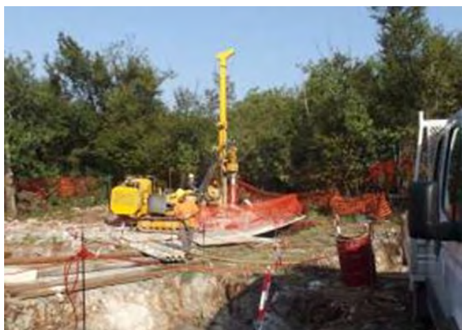
Figura 75: Esempio di realizzazione di fondazione su micropali tipo tubfix. Nell'immagine di destra è mostrato il raccordo tra i tubolari metallici dei micropali con l'armatura del plinto di fondazione; al centro del plinto si nota il moncone del sostegno (elemento di raccordo tra il sostegno e la fondazione), inglobato nella fondazione stessa.
