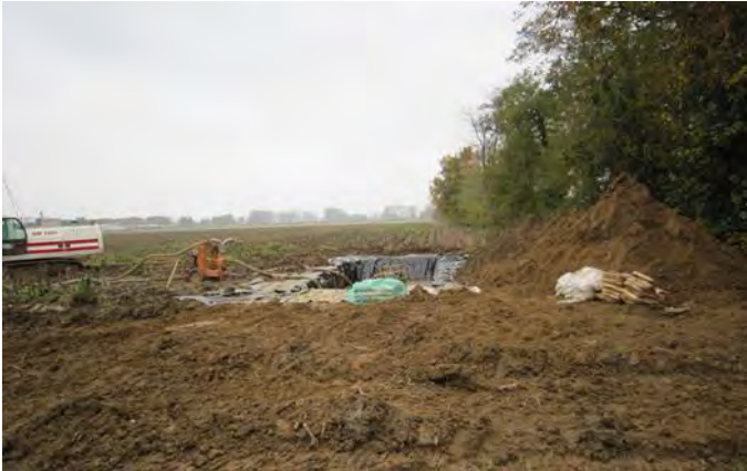
Figura 83: Allestimento di un impianto a circuito chiuso per la realizzazione di pali trivellati mediante l'utilizzo di fanghi bentonitici. In questa immagine si osservano la vasca impermeabilizzata e la vasca prefabbricata per la decantazione del fango, la pompa di rilancio del fango verso il foro e l'area di deposito dei sacchi contenenti la bentonite.
