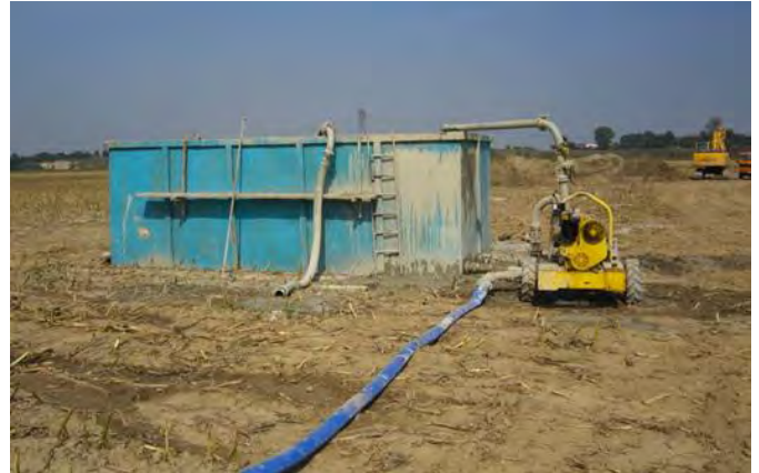
Figura 83: Allestimento di un impianto a circuito chiuso per la realizzazione di pali trivellati mediante l'utilizzo di fanghi bentonitici. In questa immagine si osservano la vasca impermeabilizzata e la vasca prefabbricata per la decantazione del fango, la pompa di rilancio del fango verso il foro e l'area di deposito dei sacchi contenenti la bentonite.
