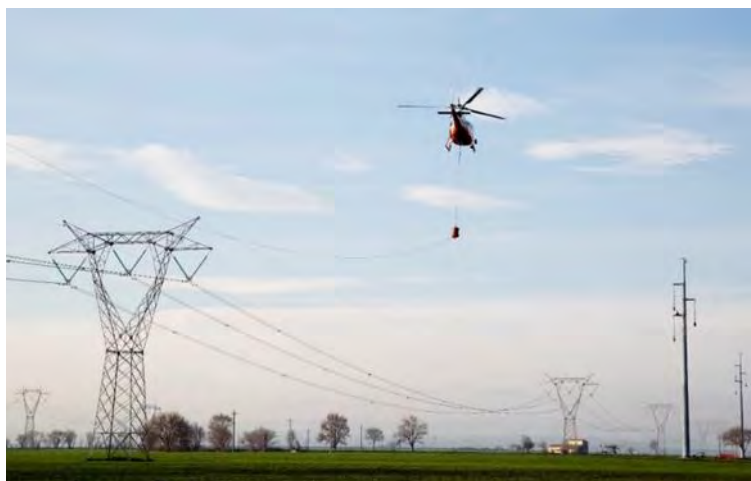
Figura 78: Utilizzo dell'elicottero per la stesura della fune pilota. A destra particolare delle carrucole
