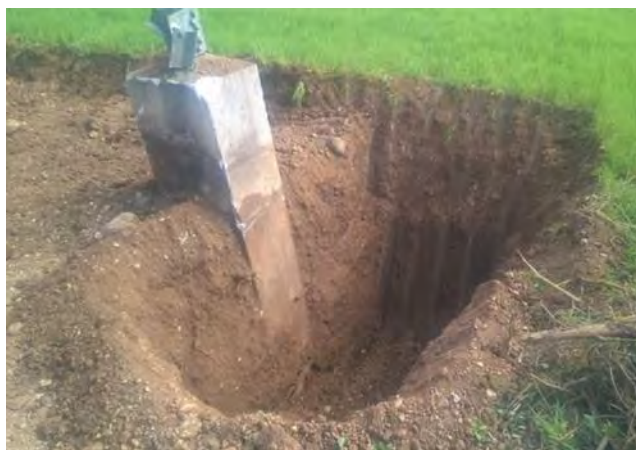
Figura 85: Esempio di rimozione della fondazione superficiale di un sostegno
