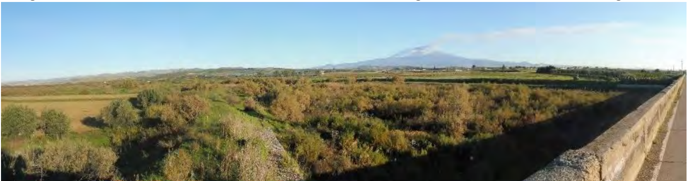
Figura 90: Vegetazione lungo il fiume Dittaino - tratto tra i sostegni 4 e 5 dell'elettrodotto Regalbuto-Sferro
