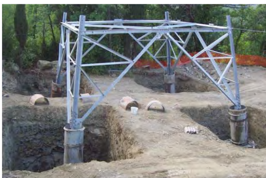
Figura 70: Realizzazione di fondazioni superficiali tipo CR per sostegno a traliccio. Si possono osservare le quattro buche, la base del sostegno collegata alla fondazione tramite i "monconi" ed i casseri utilizzati per i quattro "colonnini"
