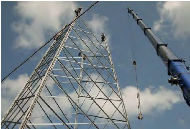
Figura 77: Fasi di montaggio sostegno a traliccio
