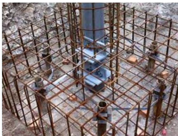
Figura 75: Esempio di realizzazione di fondazione su micropali tipo tubfix. Nell'immagine di destra è mostrato il raccordo tra i tubolari metallici dei micropali con l'armatura del plinto di fondazione; al centro del plinto si nota il moncone del sostegno (elemento di raccordo tra il sostegno e la fondazione), inglobato nella fondazione stessa.
