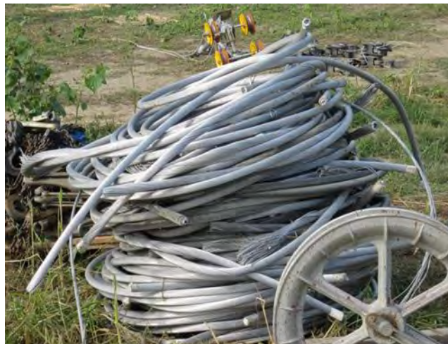
Figura 84: Fasi demolizione di un sostegno a traliccio, particolare di materiale raccolto
