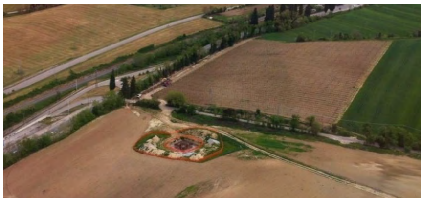
Figura 67: Area sostegno veduta dall'alto dell'estensione complessiva del micro-cantiere
