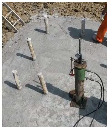
Figura 74: Realizzazione di micropali tipo tubfix per sostegno a traliccio. Particolare di micropali già realizzati ed iniettati prima dell'armatura e cassetta del plinto di fondazione.
