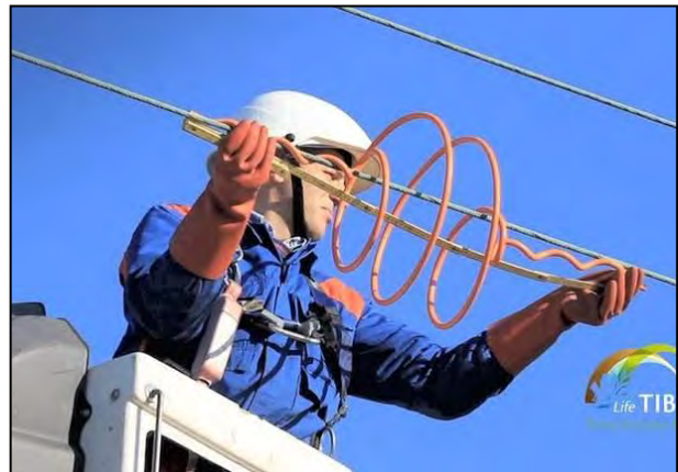
Figura 141: Dissuasore per avifauna (tipo a spirale)
