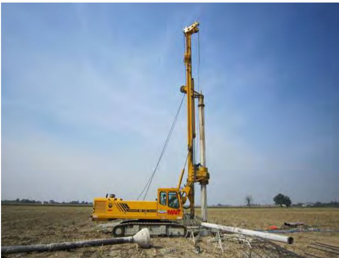
Figura 72: Macchina operatrice per la realizzazione di pali trivellati e fondazione in fase di realizzazione
