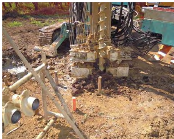
Figura 76: Macchina operatrice per la realizzazione di micropali tubfix. A sinistra sistema di scavo a rotopercussione, a destra sistema di scavo mediante trivella elicoidale.
