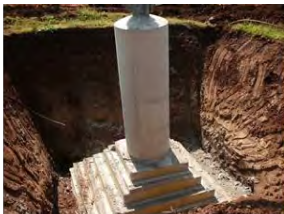
Figura 69: Realizzazione di fondazioni superficiali tipo CR per sostegno a traliccio. Particolare durante la fase di cassetatura (a sinistra) e al termine della stessa (a destra)
