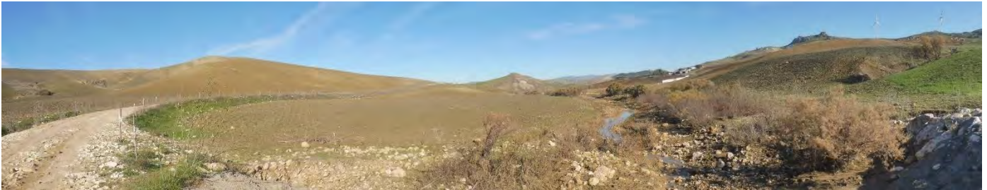
Figura 88: Attraversamento corso d'acqua minore - Vista verso sostegno 7 - Elettrodotto Assoro-Regalbuto
