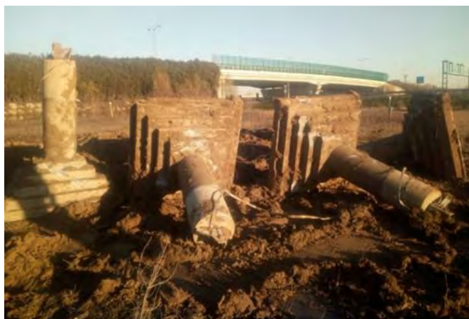
Figura 85: Esempio di rimozione della fondazione superficiale di un sostegno
