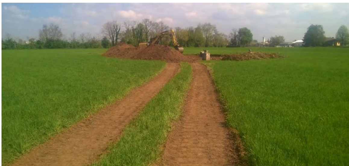
Figura 81: Esempio di pista temporanea su terreno agricolo
