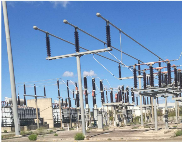
Tipico Sistema di Sbarre parallelo
