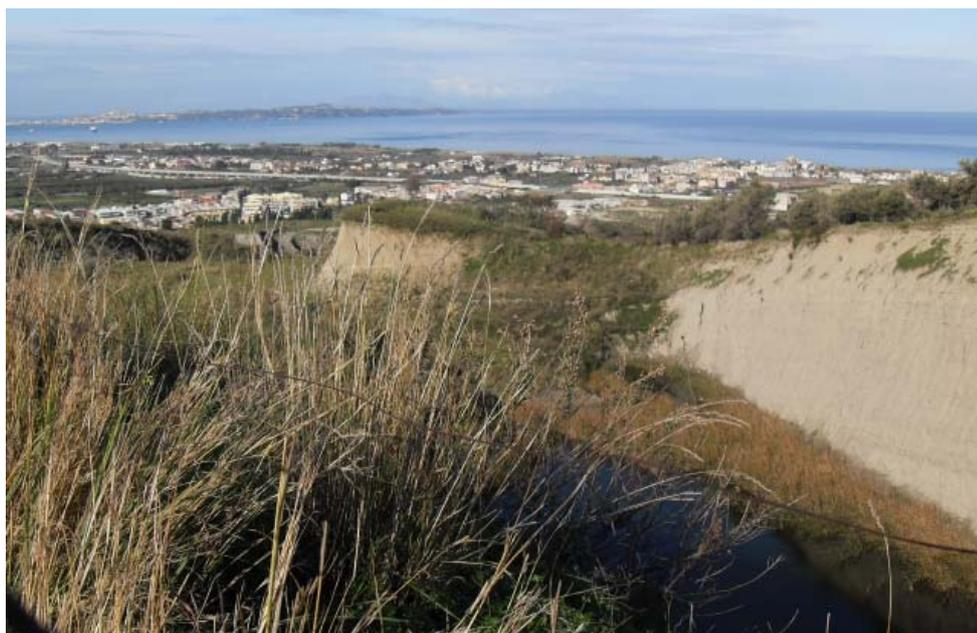
FOTO 2 – Erosioni calanchiformi lungo le pareti subverticali della cava a fossa.
