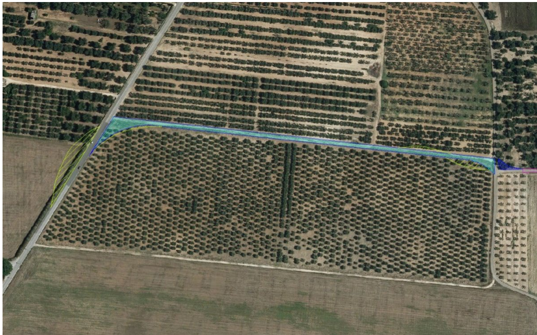
Fig.12 - Espianti ulivi area strada ingressoWTG MES07 Gli ulivi saranno reimpiantati nell'ambito della stessa area
