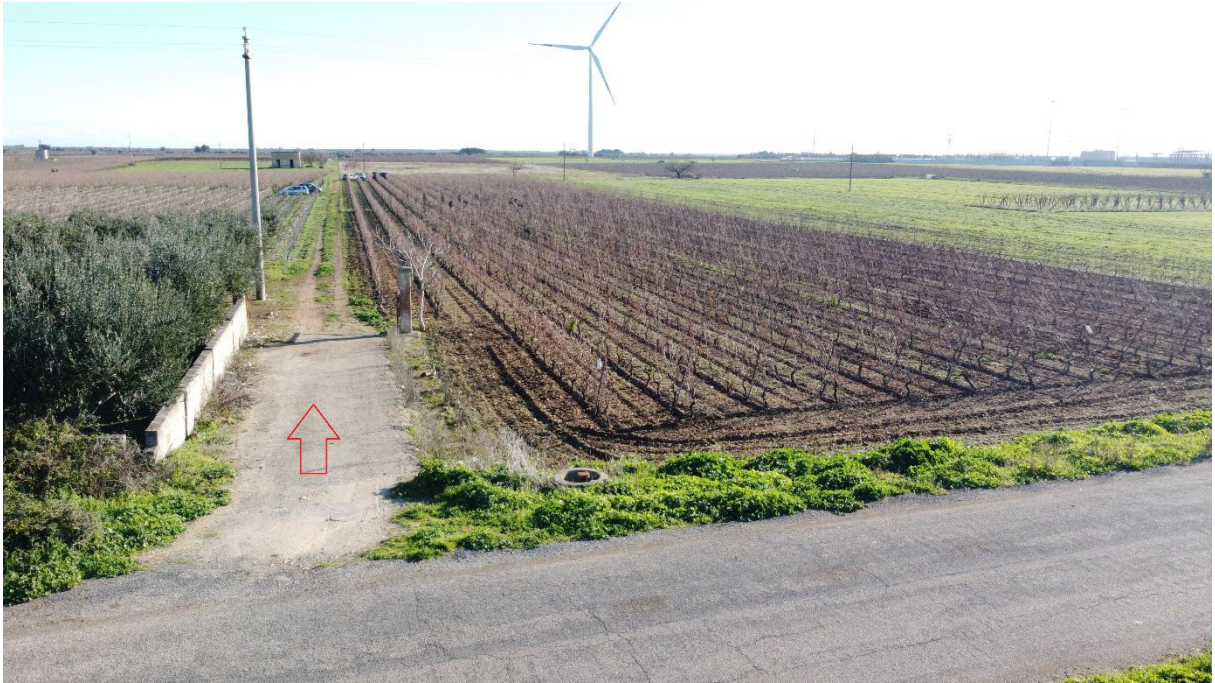
Fig. 24 - Report fotografico - Ingresso area SSE da strada pubblica SP64
