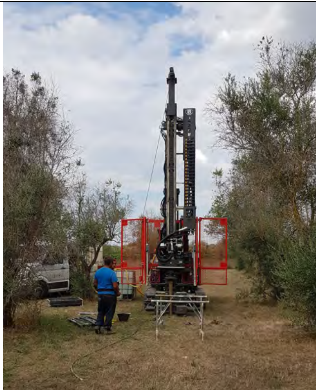
Postazione ed Esecuzione sondaggio S2
