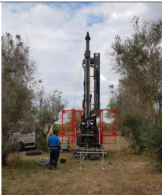
Postazione ed Esecuzione sondaggio S2
