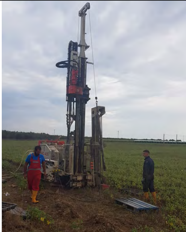
Postazione ed Esecuzione sondaggio S1
