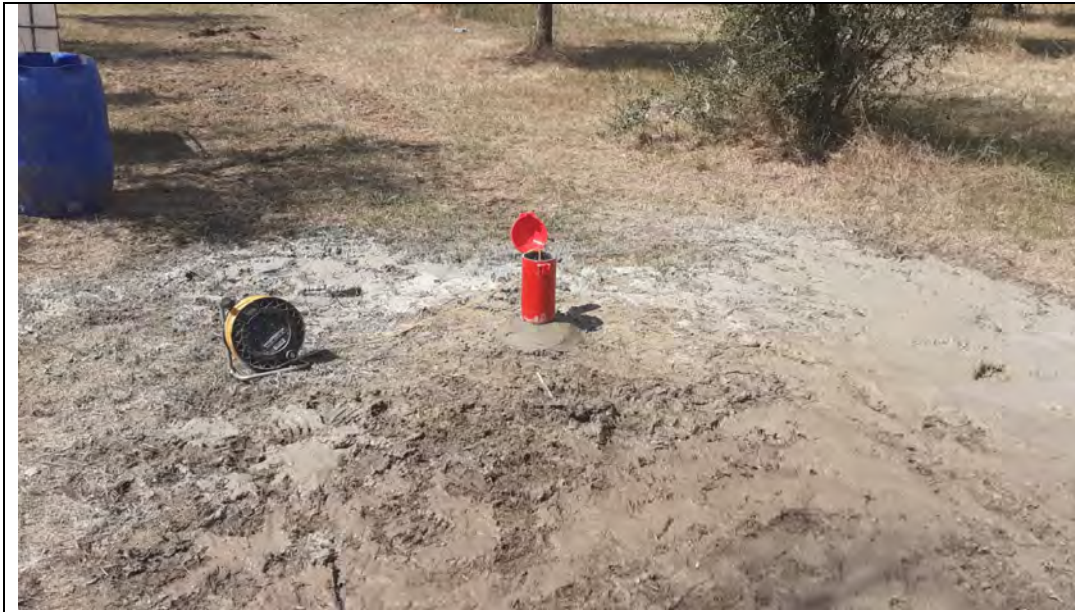
Piezometro e chiusino di protezione in corrispondenza dell'aerogeneratore MES 06
