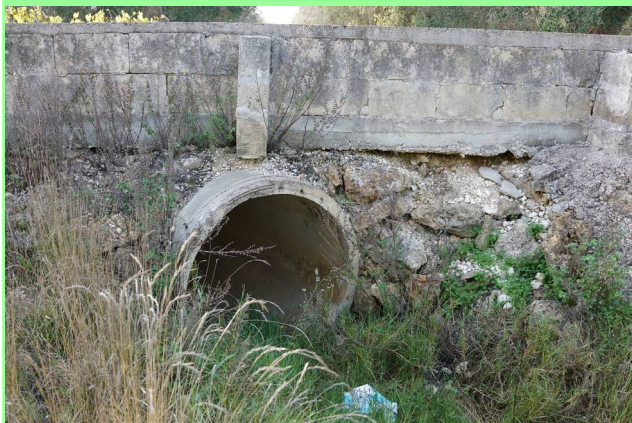
Figura 42: Canale intersecato dal tracciato del cavidotto (Punto rilievo: 19).
