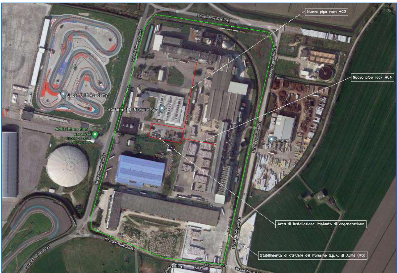
Figura 1 – Aerofoto dell'area di installazione
