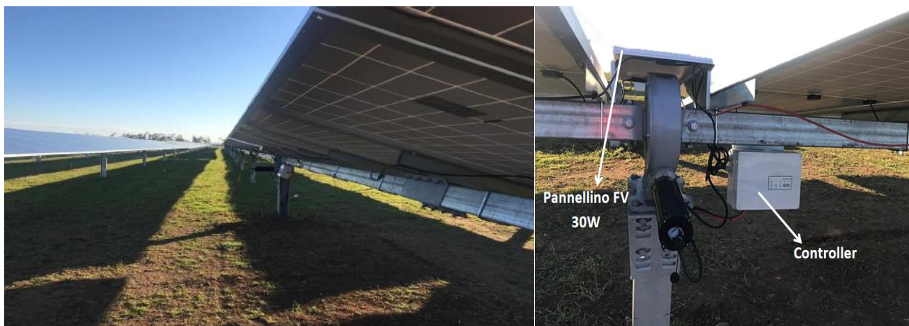
Figura 7: struttura di supporto
