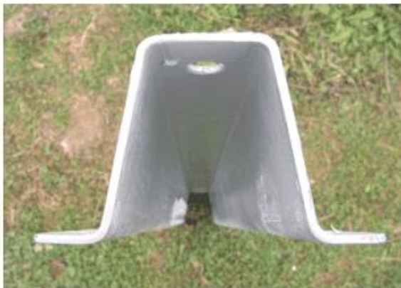
("Fondamenta") Profilo in acciaio conficcato nel terreno.
