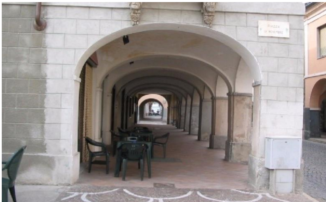
Fig. 5.13: Centro abitato di Verolengo
