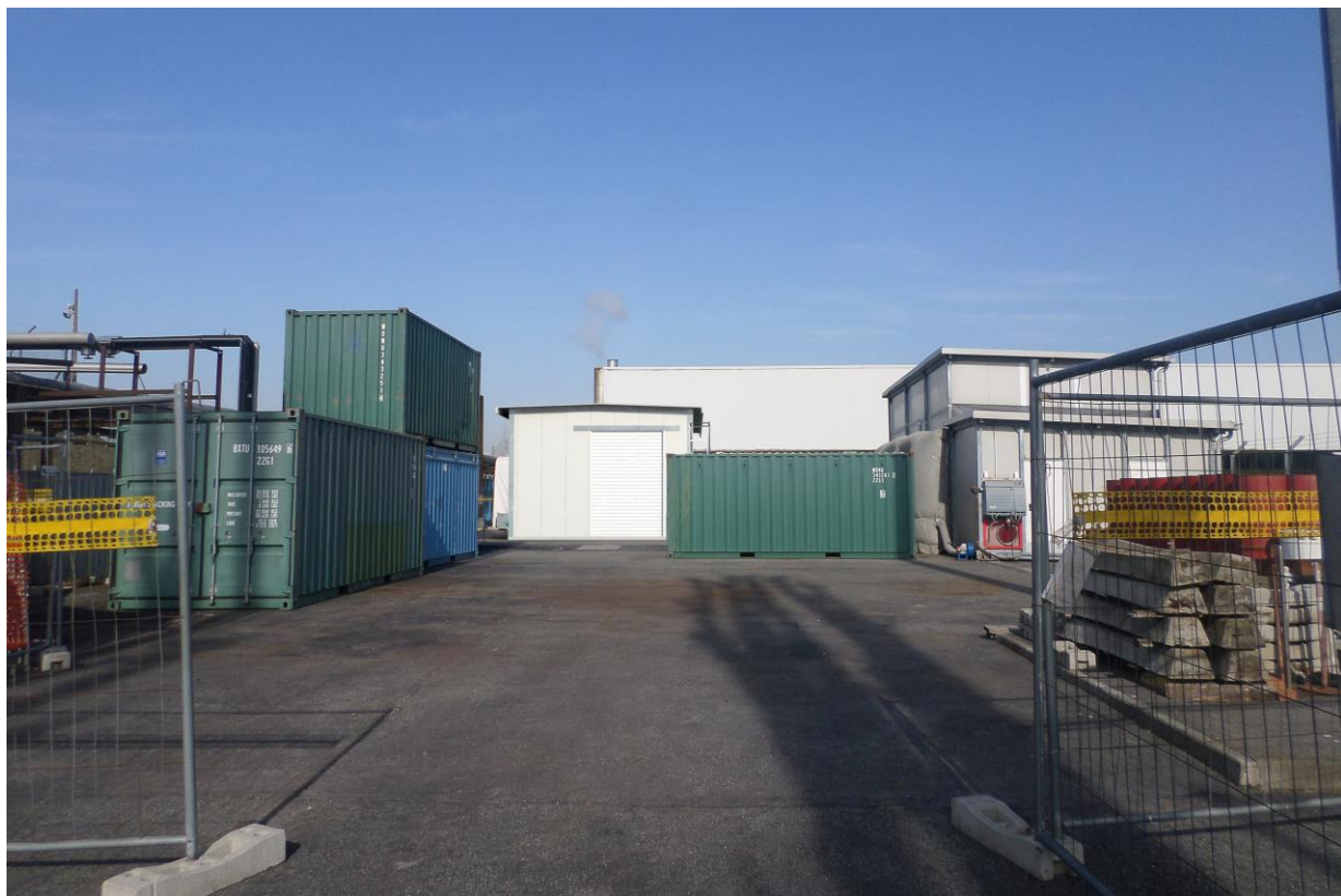
Fig. 10.4: Sistema di caratterizzazione SGS – situazione post operam
