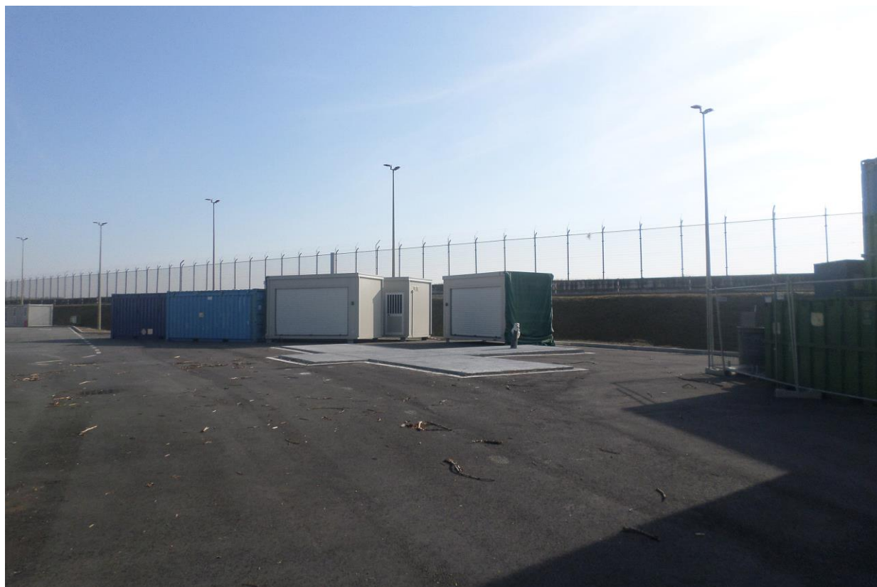
Fig. 10.1: Box Counter – situazione ante operam
