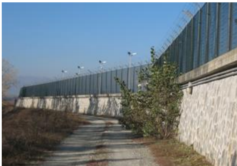
Fig. 6.4: Impianto Eurex, muro di difesa idraulica
