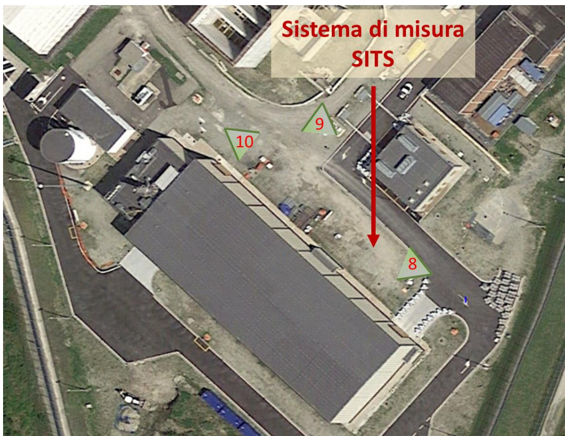
Fig. 9.10: Area di realizzazione Sistema SITS e indicazione dei punti di ripresa fotografica
