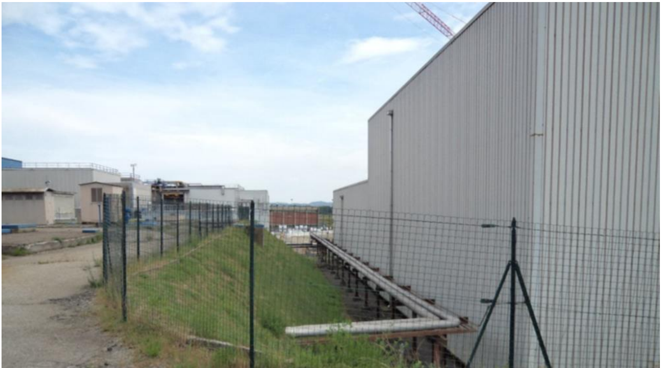
Figura 5-4 Ante operam: vista Est con scarpata e pipe rack esistente
