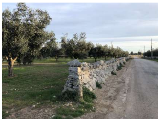
Figura 15 - Esempio di muretto a secco
