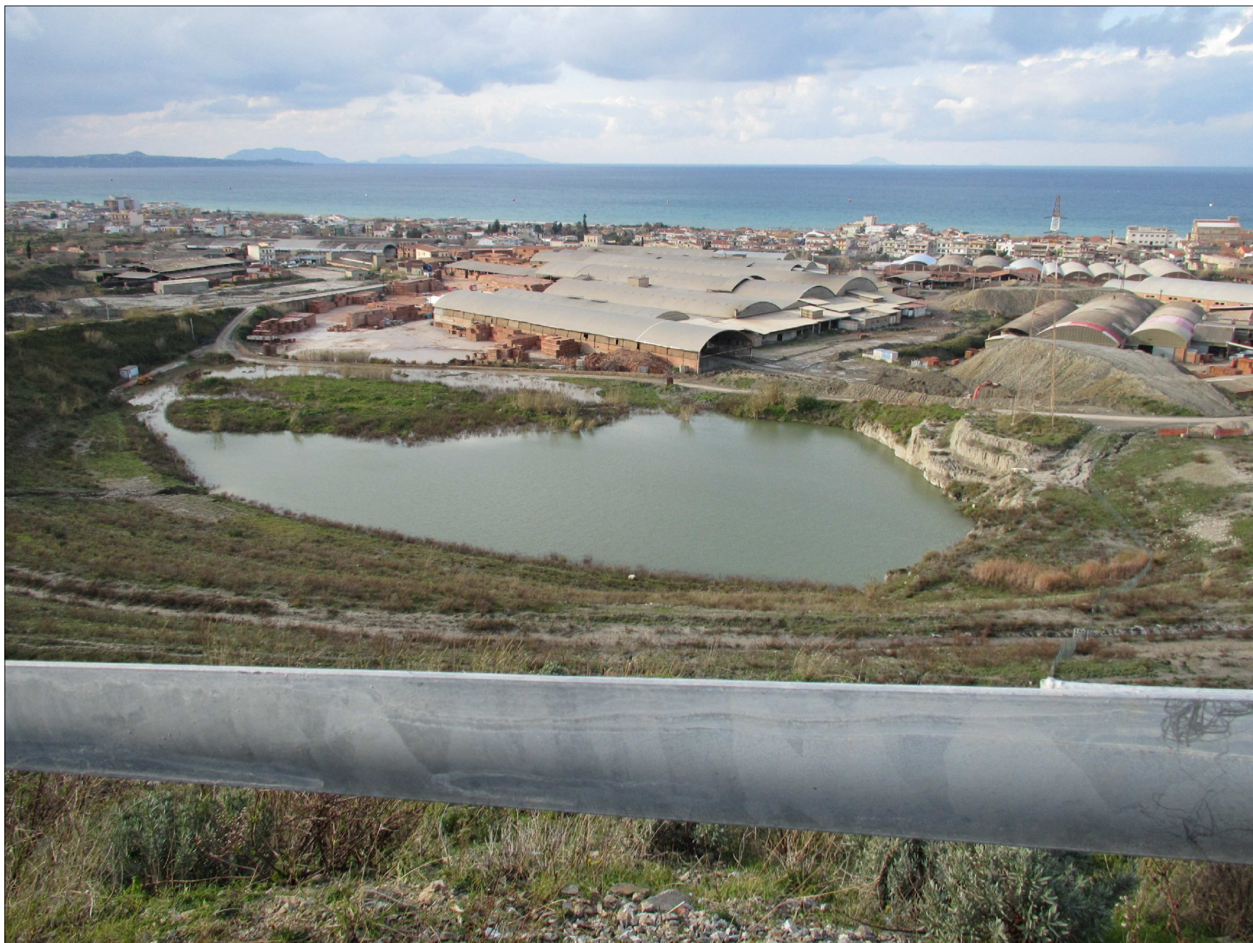
Fig. 1c – Foto del sito SRA9 visto da Sud
