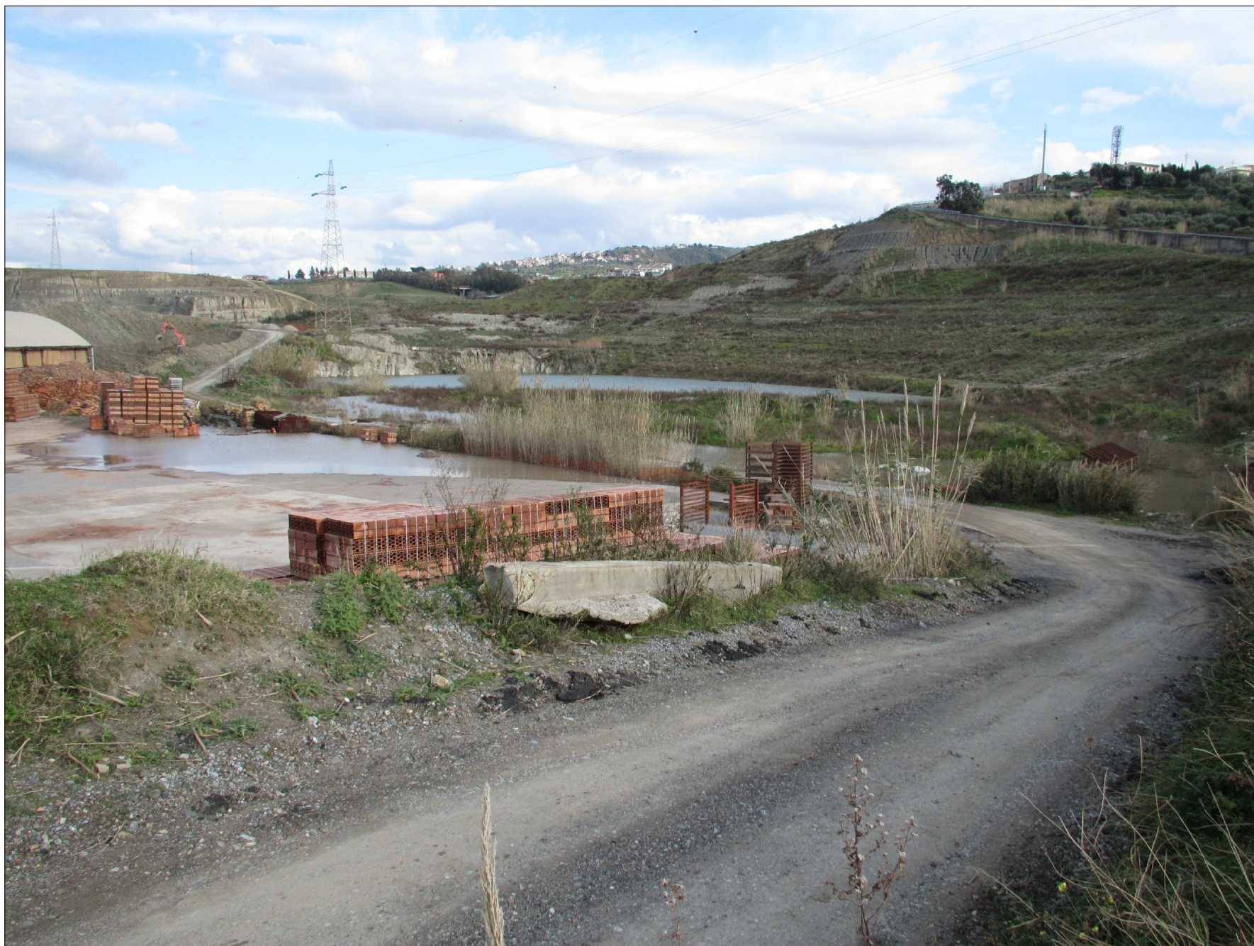
Fig. 1b – Foto del sito SRA9 visto da Nord
