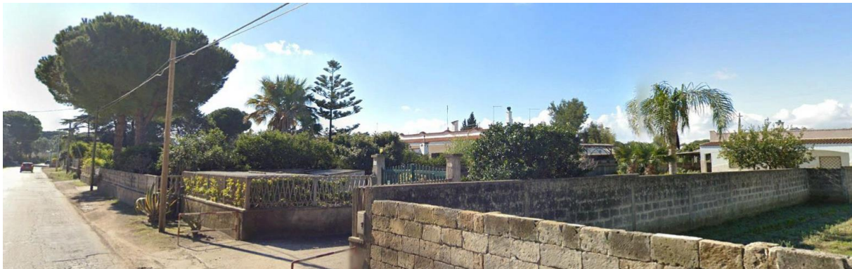
Figura 94 Latiano punto di presa uscita SP 70
