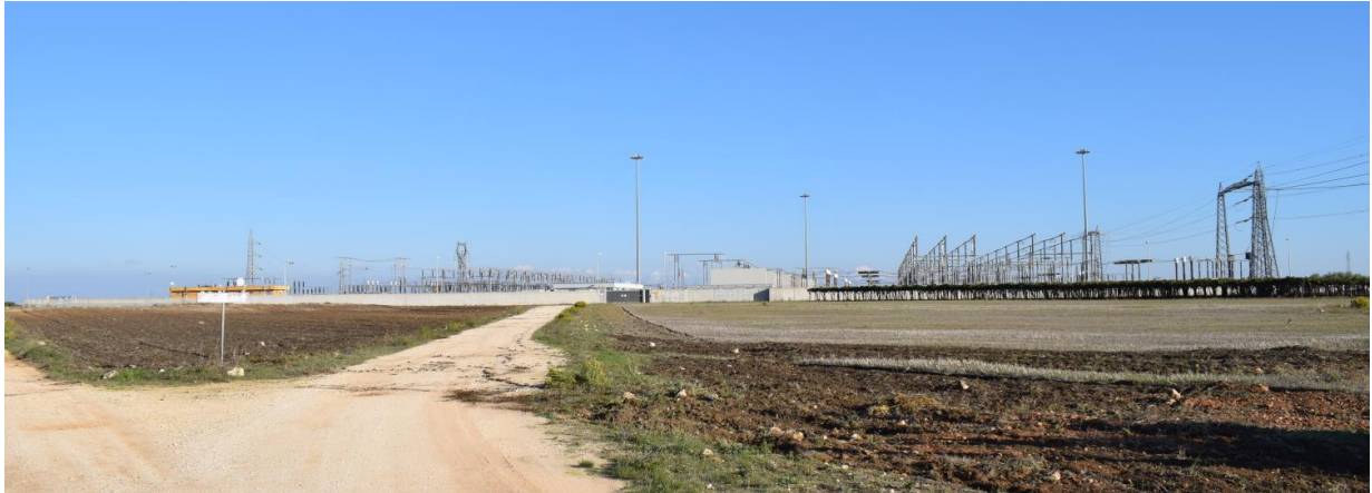
Figura 33 Stazione Elettrica Terna Erchie.
