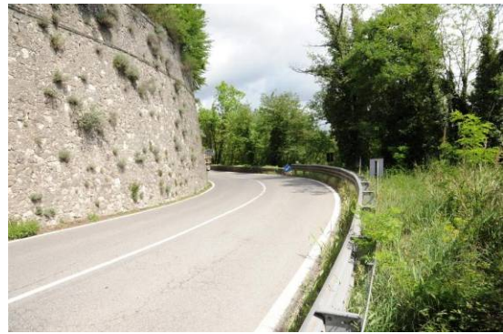
Foto 10 - vista verso ovest sullo sfondo il " Nodo 1 "
