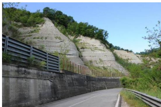
Foto 04 - vista verso ovest sullo sfondo il " Nodo 1 "
