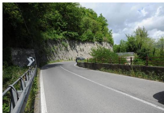
Foto 06 - vista verso ovest sullo sfondo il " Nodo 1 "
