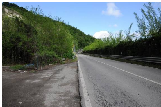
Foto 01 - vista verso ovest sullo sfondo il " Nodo 1 "
