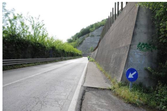
Foto 02 - vista verso est tratto (sul fondo) " Nodo 2 "
