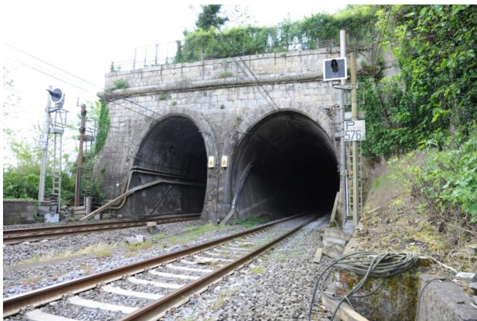
Foto 27 – Vista verso est dal tracciato ferroviario, in dettaglio la galleria ferroviaria esistente che verrà prolungata e, al di sopra, la viabilità oggetto di variante che verrà rettificata - " Nodo 2 "
