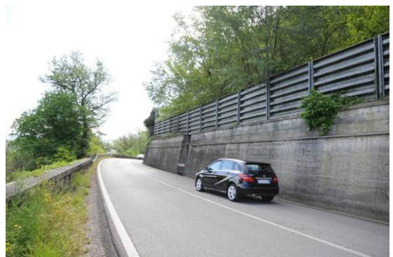
Foto 13 - vista verso est della curva " Nodo 2 "
