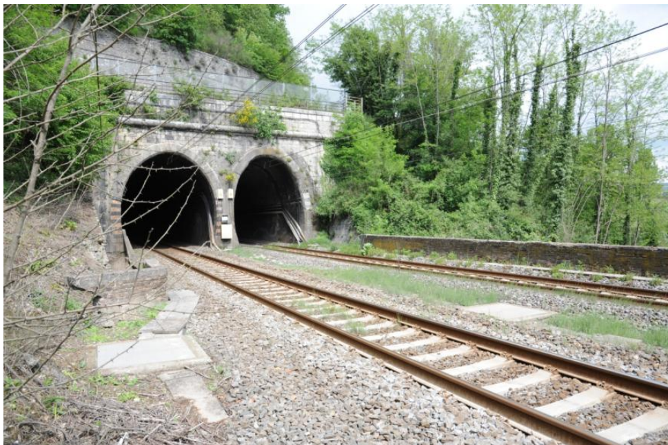
Foto 26 – Vista verso ovest dal tracciato ferroviario, in dettaglio la galleria ferroviaria esistente che verrà prolungata e, al di sopra, la viabilità oggetto di variante che verrà rettificata ( Nodo 1 )
