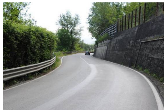
Foto 12 - vista verso est della curva " Nodo 2 "
