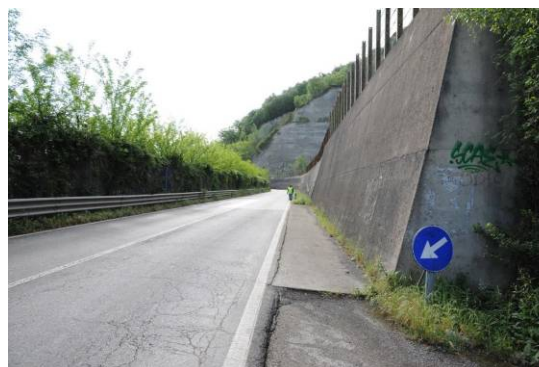
Foto 02 - vista verso est sullo sfondo il " Nodo 2 "
