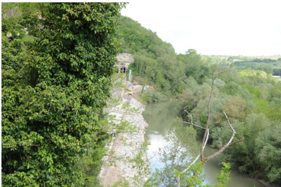
Foto 15 - vista complessiva verso ovest: Fiume Paglia e sullo sfondo l'imbocco della galleria ferroviaria e la sovrastante curva del " Nodo 1 "
