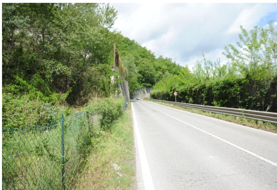
Foto 18 – Vista complessiva verso ovest del tratto rettilineo della S.S. 205 "Amerina" interessato dalla variante del " Nodo 1 " posto al di sopra della linea ferroviaria.
