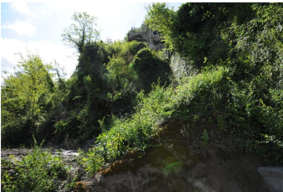
Foto n° 34 – Visuale est dal livello del Fiume Paglia: area interessata dai lavori per la realizzazione del " Nodo 2 ", in alto al centro, la galleria ferroviaria esistente.
