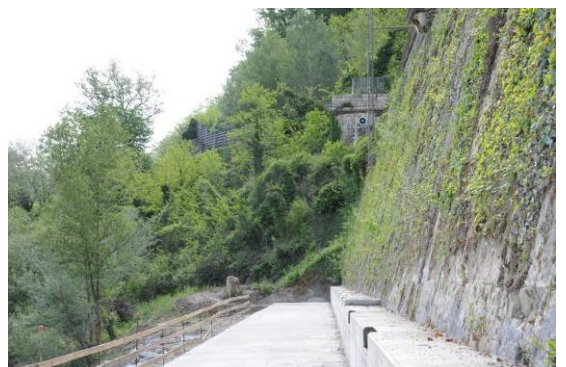
Foto 23 - visuale est (dal Fiume Paglia) tratto " Nodo 2 "
