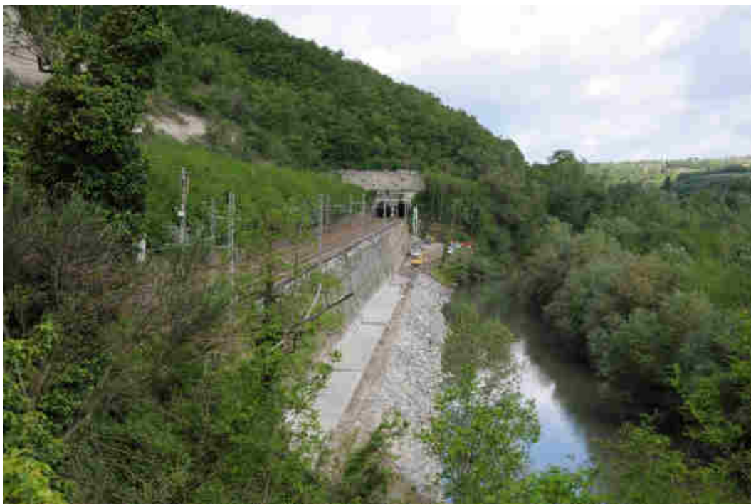
Figura 2.4 Vista complessiva verso ovest. Dall'alto a sinistra scendendo verso destra è possibile scorgere i calanchi, la viabilità (nodo 1), la ferrovia, i lavori in corso di RFI, il Fiume Paglia
