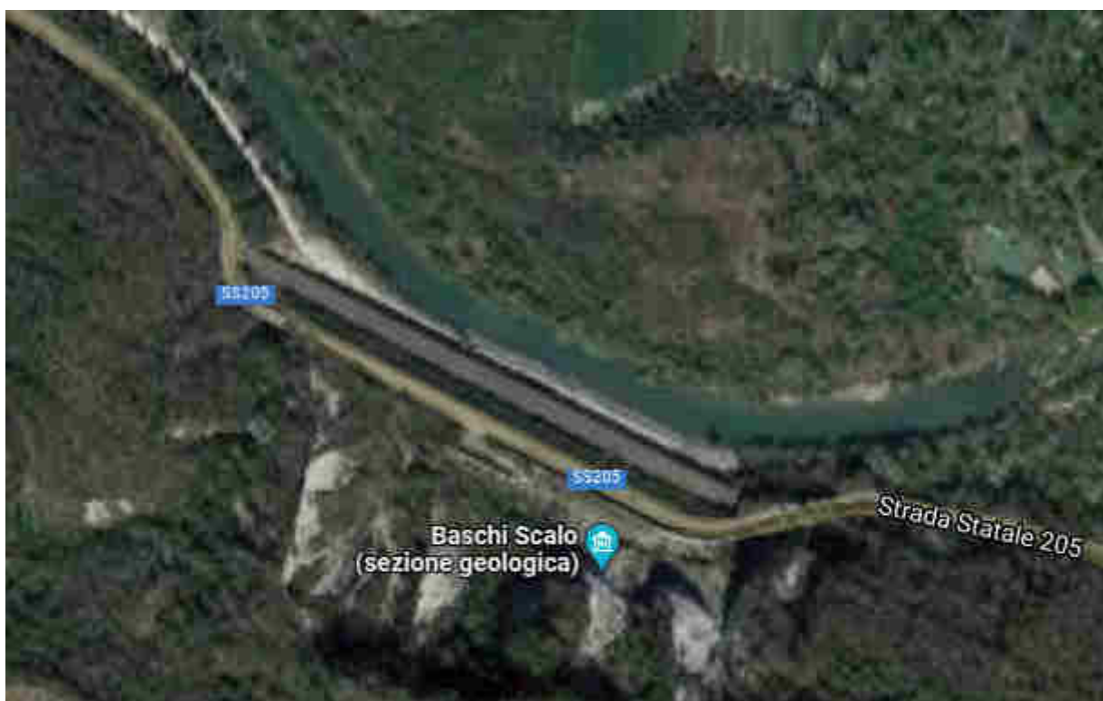
Figura 1.1 Vista aerea della zona di intervento
