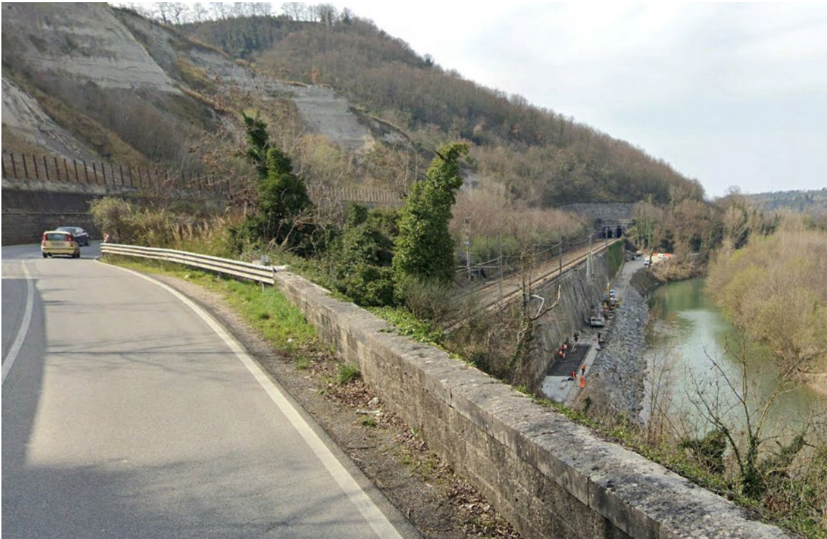
Figura 4 - Foto lato valle
