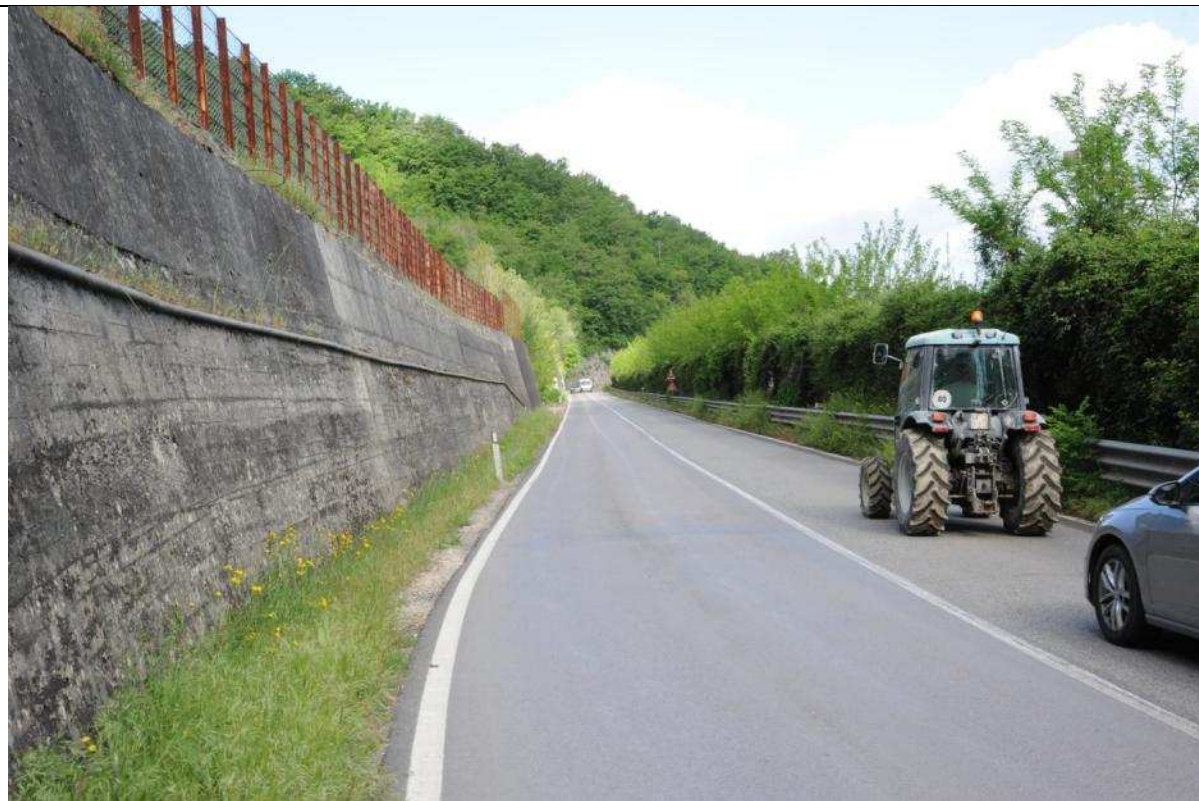
Foto n° 11 – Vista verso ovest della curva oggetto di miglioramento della viabilità esistente e del tratto rettilineo (variante nodo 02)
