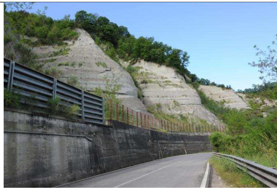
Foto n° 04 – Vista verso ovest dei calanchi retrostanti la barriera paramassi. Calanchi che costituiscono un valore ambientale
