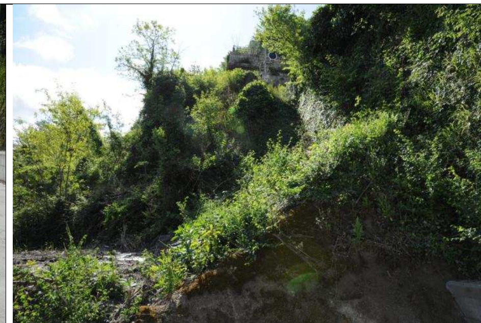
Foto n° 34 – Vista verso est dal livello del Fiume Paglia. In dettaglio l'area interessata dai lavori per la realizzazione del nodo 2. In alto al centro, la galleria ferroviaria esistente.
