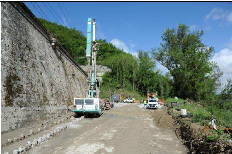
Foto n°29 – Vista verso ovest dal livello del Fiume Paglia. Sulla sinistra il tracciato ferroviario e sullo sfondo la galleria del nodo 1.
