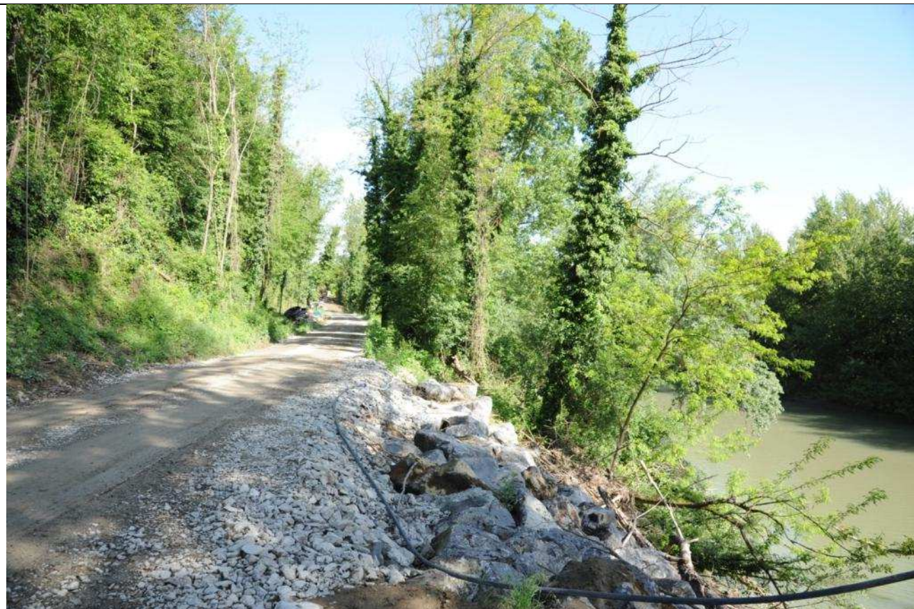
Foto n° 35 – Vista verso ovest della viabilità che verrà utilizzata per il cantiere.
