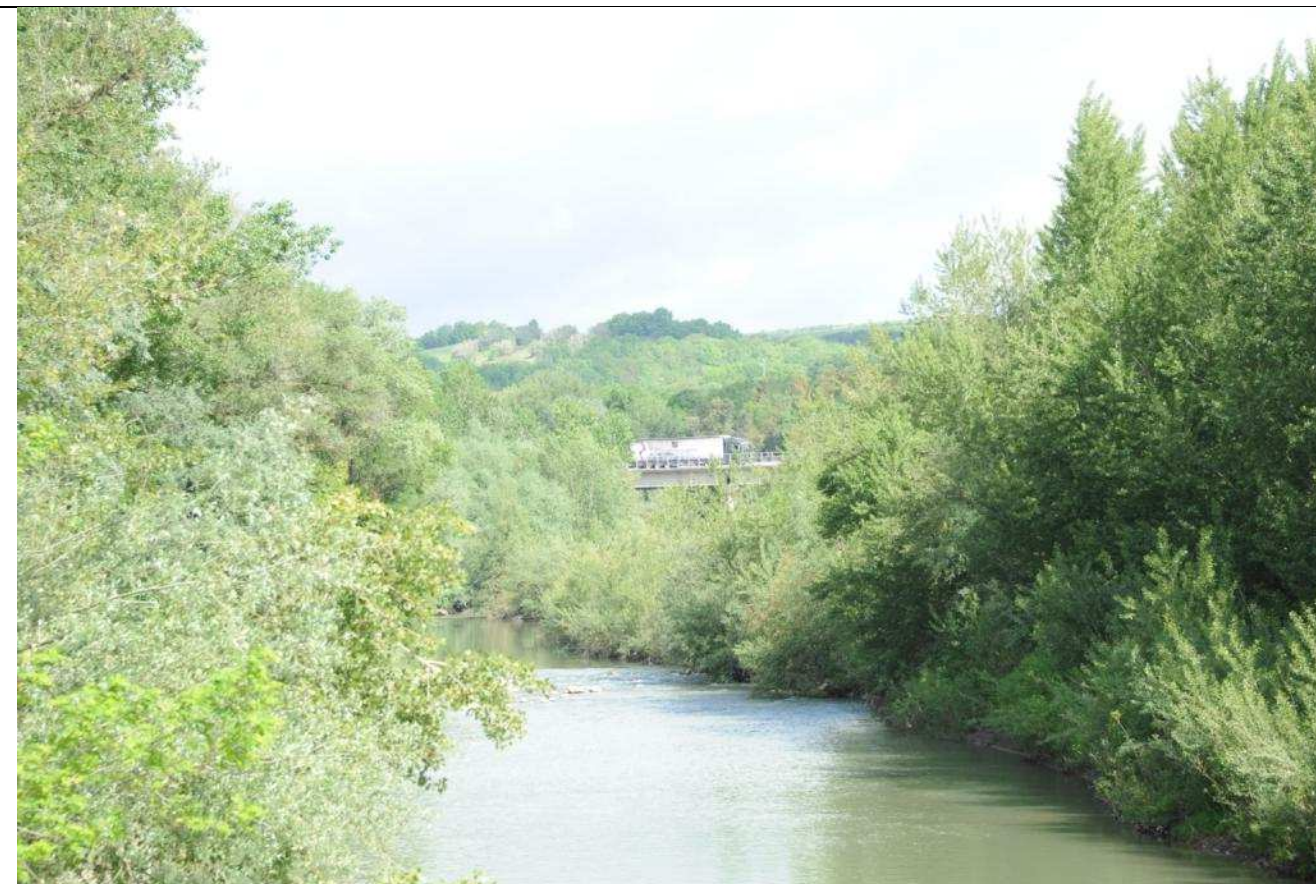
Foto n° 46 – Vista verso nord ovest, in primo piano il Fiume Paglia, al centro un viadotto dell'autostrada A1.
