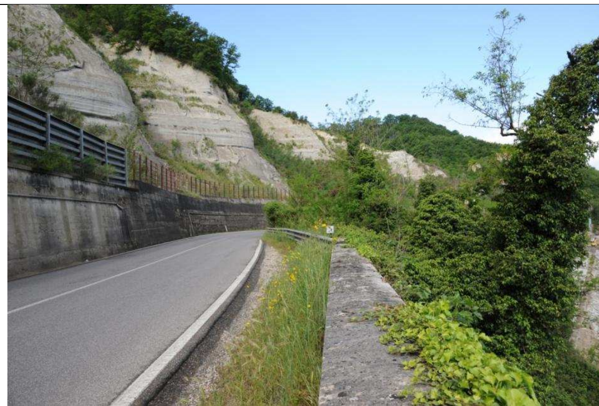
Foto n° 14 – Vista verso ovest della curva oggetto di miglioramento della viabilità esistente (variante nodo 02)
