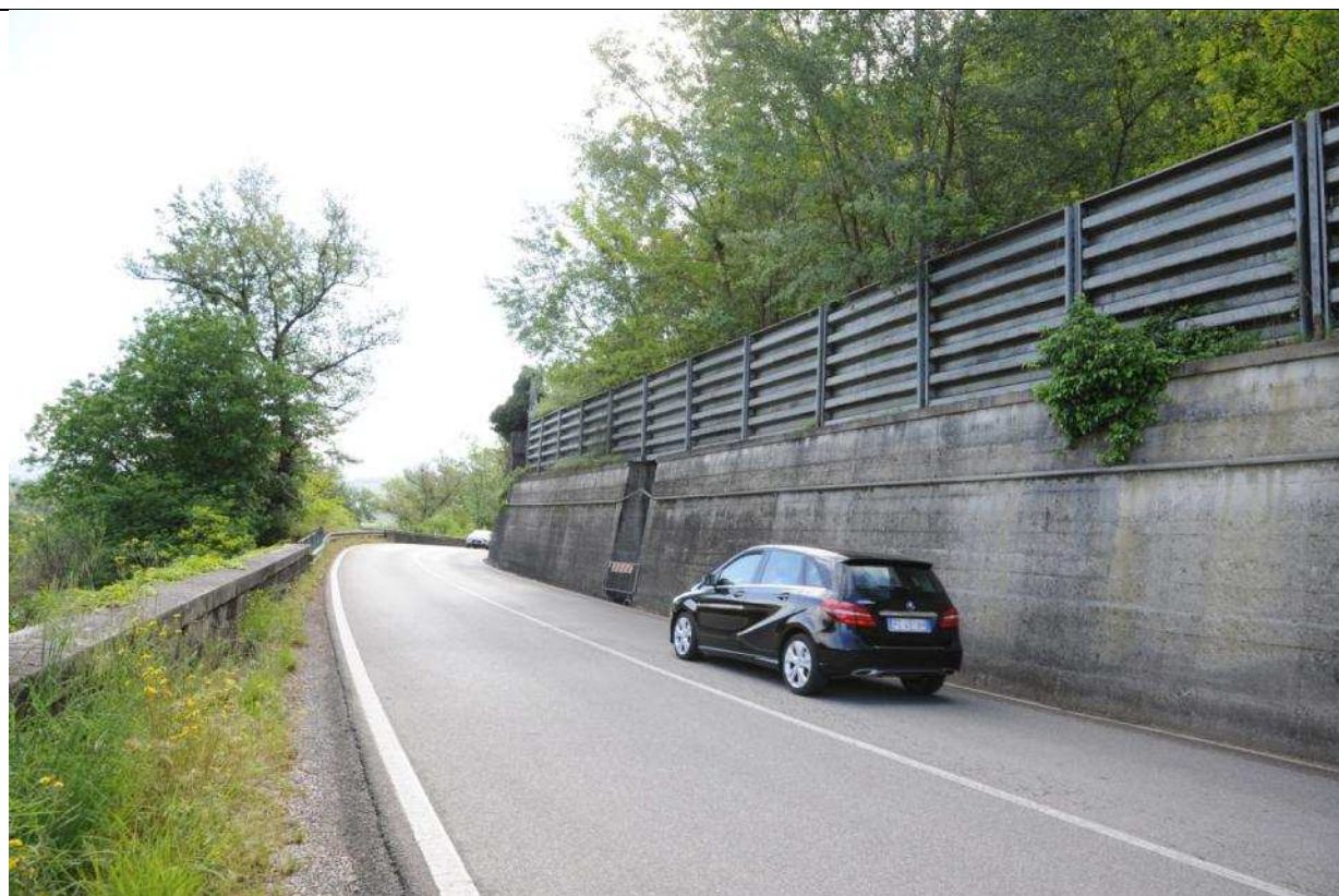
Foto n° 13 – Vista verso est della curva oggetto di miglioramento della viabilità esistente (variante nodo 02)
