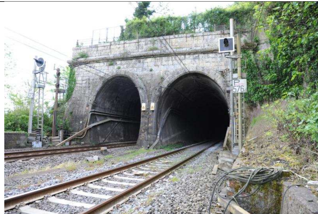
Foto n° 27 – Vista verso est dal tracciato ferroviario, in dettaglio la galleria ferroviaria esistente che verrà prolungata e, al di sopra, la viabilità oggetto di variante che verrà rettificata (nodo 2)
