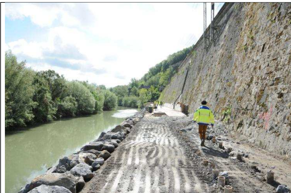
Foto n° 32 – Vista verso est dal livello del Fiume Paglia. Sulla destra il tracciato ferroviario e sullo sfondo la galleria del nodo 2.
