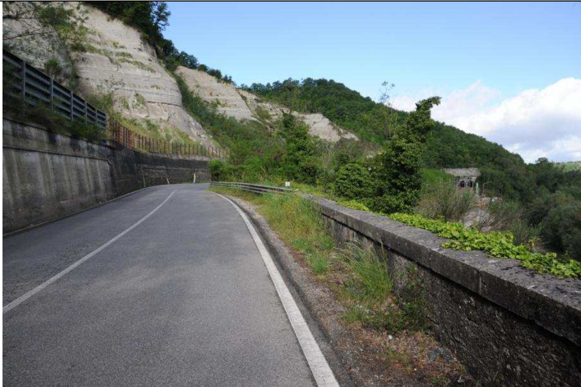
Foto n° 22 – Vista verso ovest del tratto interessato dall'adeguamento della viabilità del nodo 2 sovrastante il tracciato ferroviario
