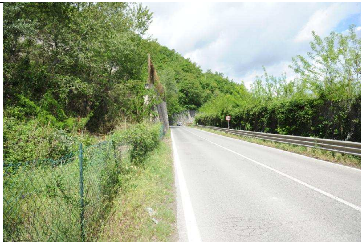
Foto n° 18 – Vista complessiva verso ovest del tratto rettilineo della SS. Amerina interessato dalla variante del nodo 1 posto al di sopra della linea ferroviaria.
