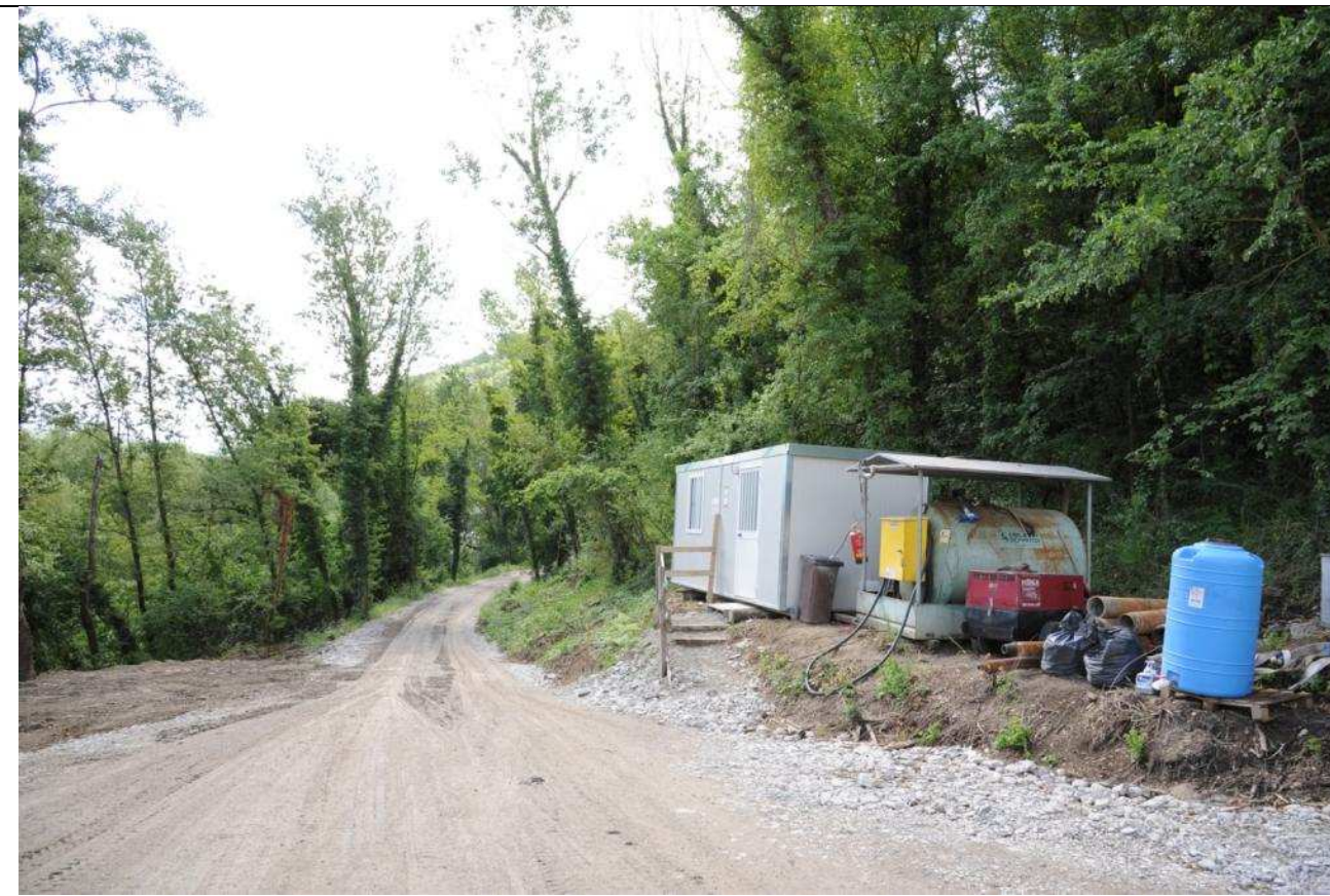
Foto n° 36 – Vista verso st della viabilità che verrà utilizzata per il cantiere.
