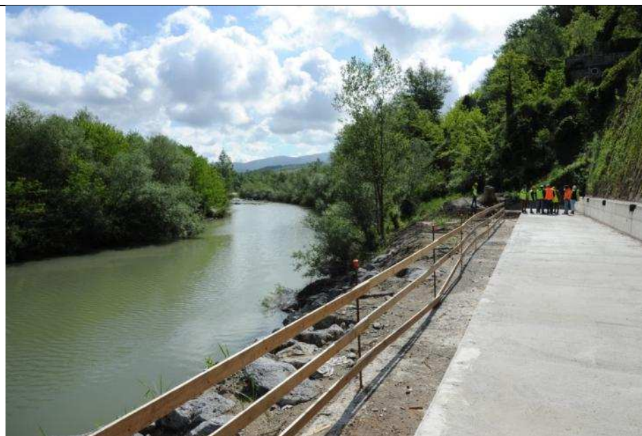
Foto n° 33 – Vista verso est dal livello del Fiume Paglia. In primo piano le opere in corso di realizzazione da RFI che verranno utilizzate anche per il cantiere in progetto (nodo 2).
