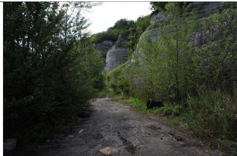
Foto n° 03 – Vista verso est dei calanchi retrostanti la barriera paramassi (muro in c.a.). Calanchi che costituiscono un valore ambientale
