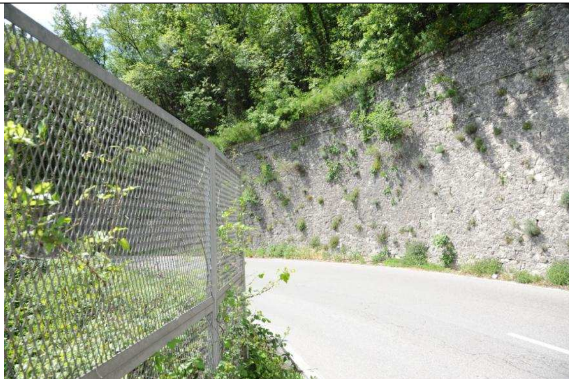
Foto n° 09 – Vista della S.S. 205 Amerina verso sud della curva oggetto di miglioramento della viabilità esistente (variante nodo 01)
