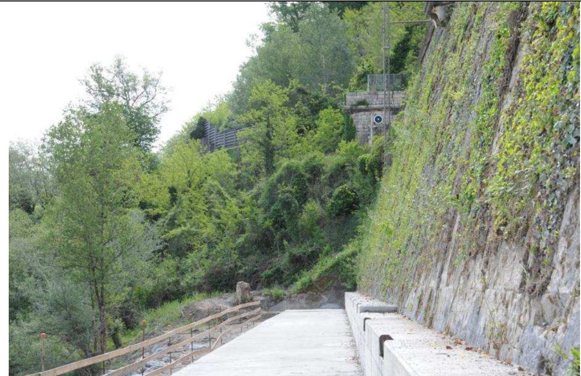
Foto n° 23 – Vista verso est dal Fiume Paglia del tratto interessato dall'adeguamento della viabilità. Sulla destra, in alto, l'imbocco della galleria e, al di sopra, la viabilità del nodo 2
