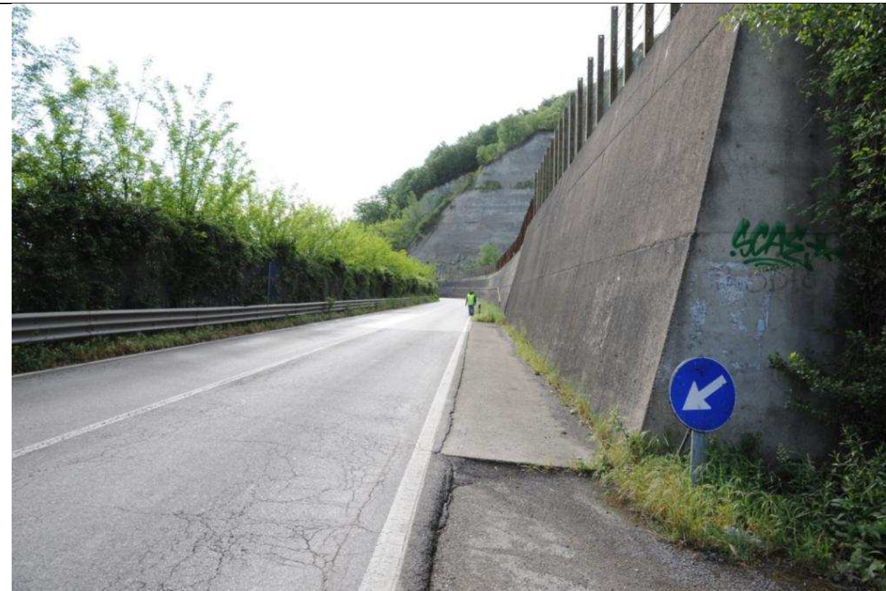
Foto n° 02 – Vista verso est della S.S. 205 Amerina nel tratto rettilineo oggetto dell'intervento. Sullo sfondo la curva del nodo 02, e sulla destra il muro paramassi
