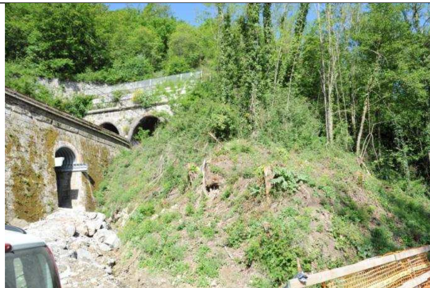
Foto n° 30 – Vista verso ovest dal livello del Fiume Paglia. In primo piano l'area che verrà interessata dai lavori per la realizzazione del nodo 1.
