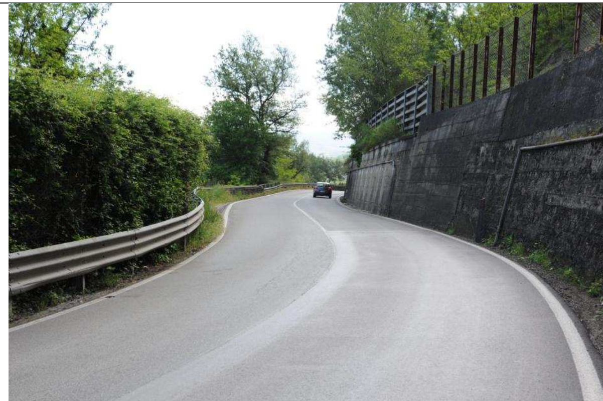
Foto n° 12 – Vista verso est della curva oggetto di miglioramento della viabilità esistente (variante nodo 02)
