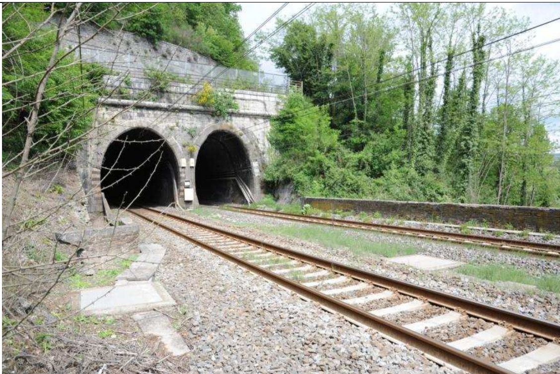
Foto n° 26 – Vista verso ovest dal tracciato ferroviario, in dettaglio la galleria ferroviaria esistente che verrà prolungata e, al di sopra, la viabilità oggetto di variante che verrà rettificata (nodo 1)
