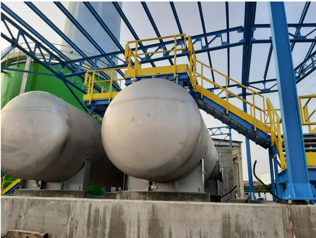
Foto 4 – Vista impianto di stoccaggio ammoniaca e struttura tettoia
