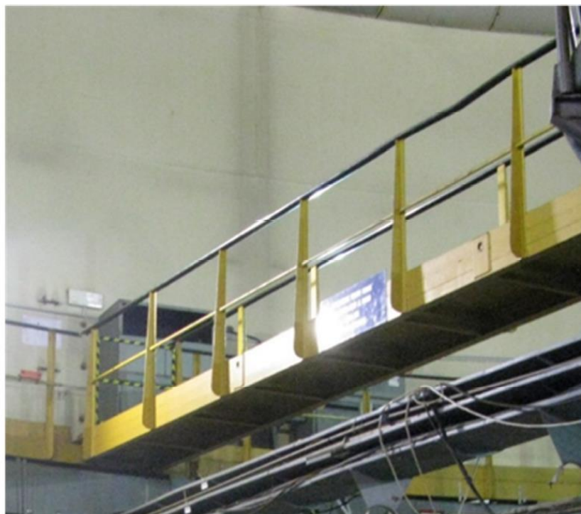
Figura 6–21 Ponte pedonale di accesso al blocco pila quota +9.30 m
