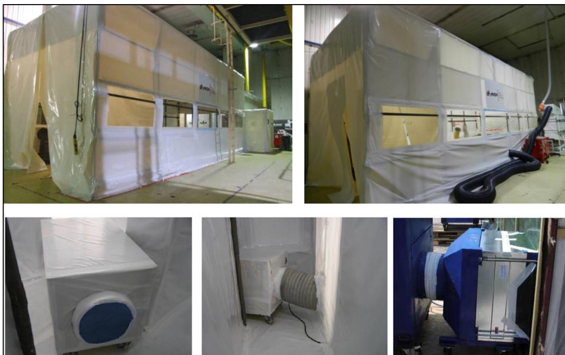
Figura 6–24 Capannine di confinamento e sistema di filtrazione (tipologici)
