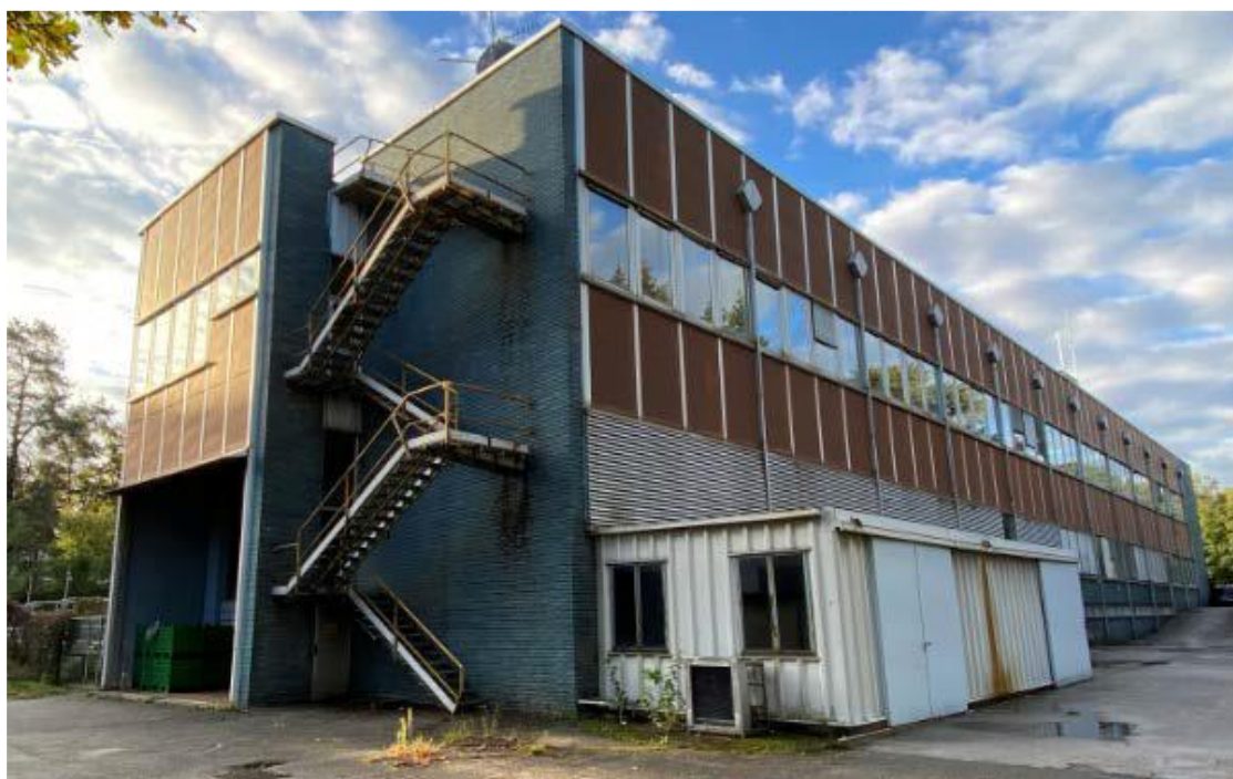
Figura 6–5 Edificio 21n – in basso a destra il container annesso da demolire
