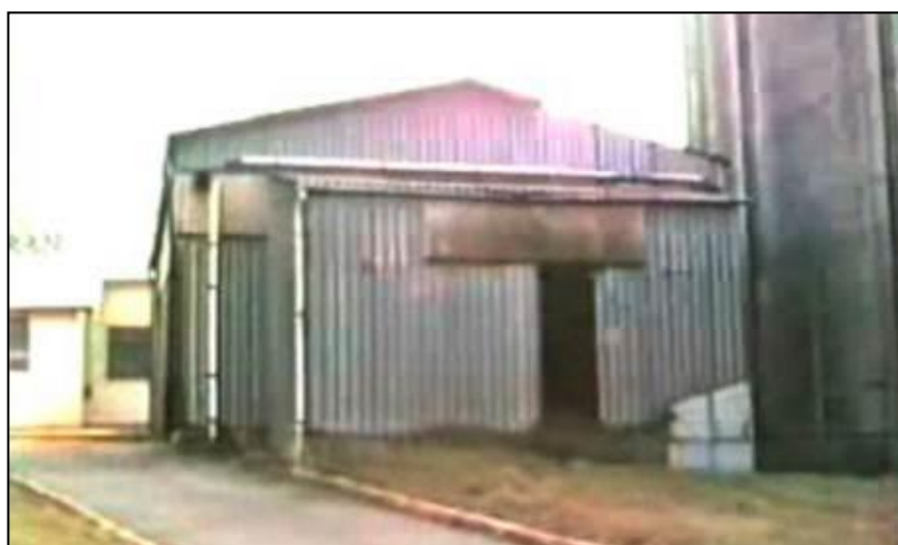
Figura 3-3: Edifici 21b e 21g nel 1993 prima della rimozione della struttura metallica
