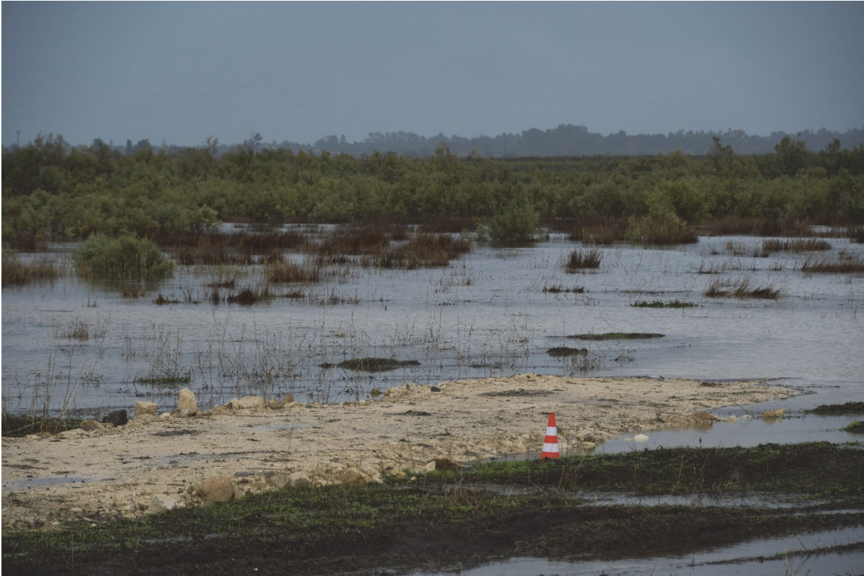
Foto 10 - Tratto di pista, in parte sommerso dalle acque, realizzato con materiale di riporto (cantiere del sostegno 33) – Foto scattata al pantano Lentini il 26 ottobre 2021.
