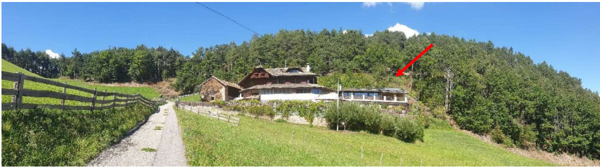
Figura 15: Chalet Grumer Suites & Spa, direttamente dietro di esso corre la variante selezionata e l'alternativa A (la freccia rossa mostra un punto d'angolo del percorso, probabilmente una posizione del palo)
